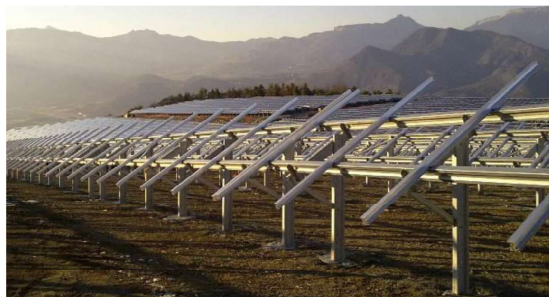
Figure 5 - Exemple de fondations en pieux battus
