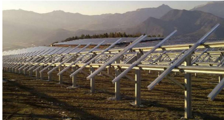
Figure 5 - Exemple de fondations en pieux battus
