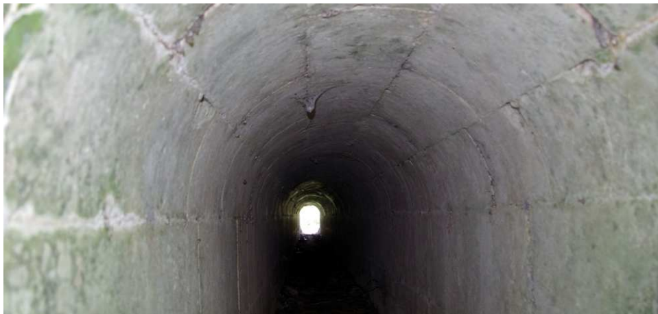
Figure 28 : Pont sous la RD137
