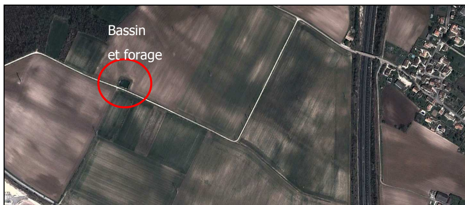
Figure 19 : forage et bassin de stockage sur le site de la Z.A.C.
