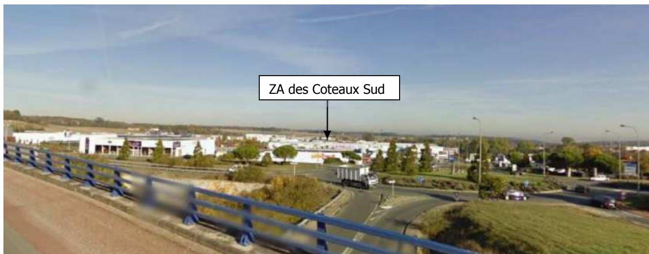
Vue n°2 : Point haut de franchissement au niveau de l'accès à la ZA existante
