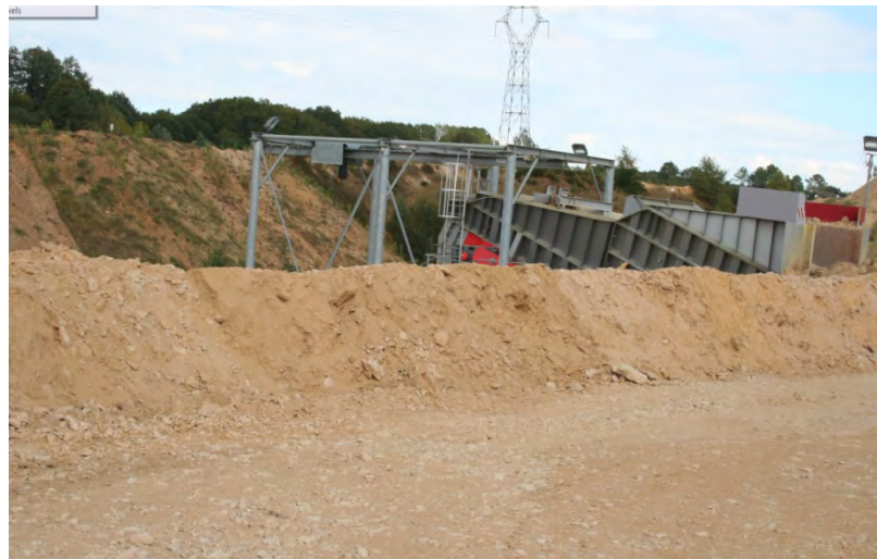
Merlons de terre en bordure des pistes
