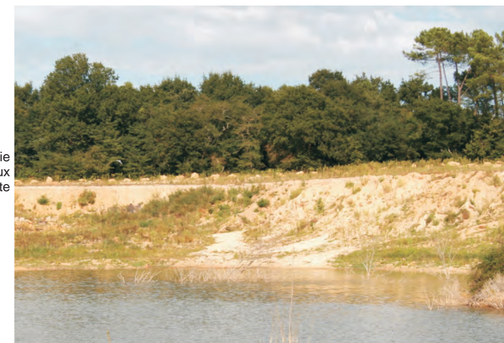
Modelé des « digues » talutées en pentes plus fortes et stabilisées par la végétation en cours de développement. A noter, en partie inférieure, les calcaires laissés en place pour éviter le fluage des matériaux déversés.
