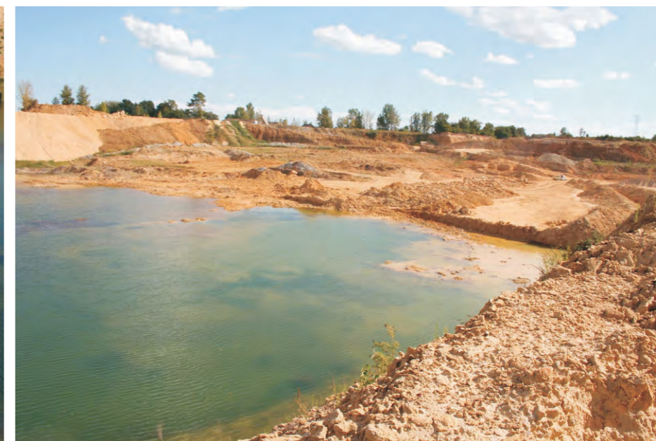
Secteur en cours de remblaiement avec des stériles et des matériaux de découverte
