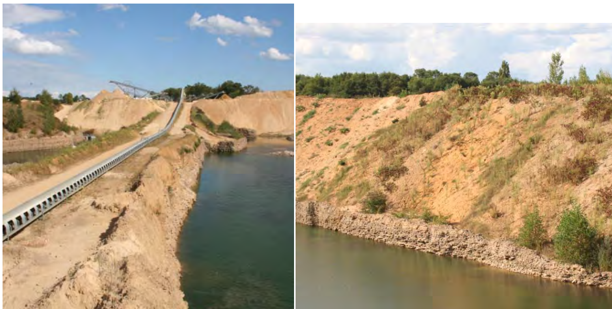
Réalisation de « digues » sur l'exploitation en cours
