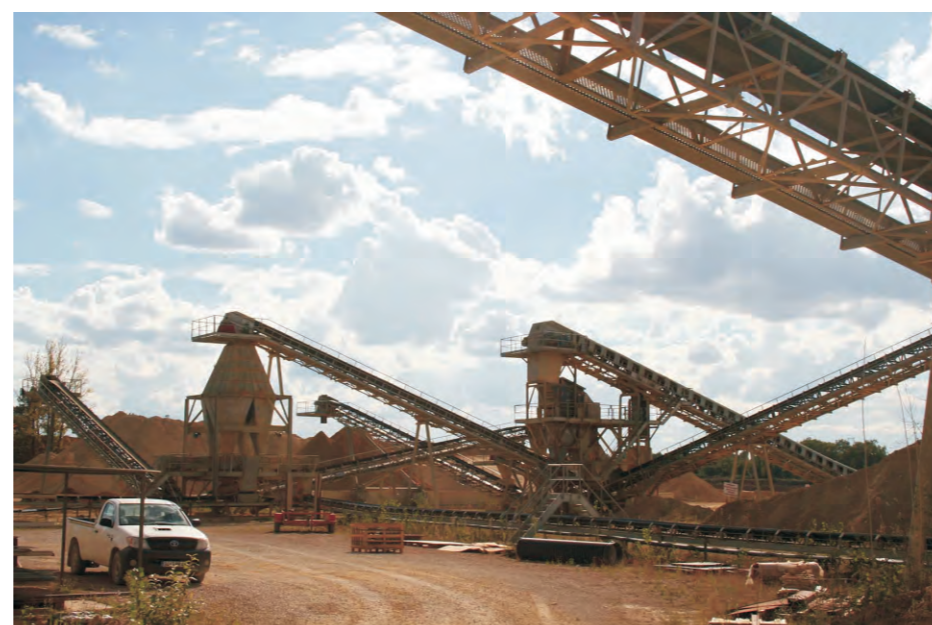
Crible secondaire et traitement des sables
