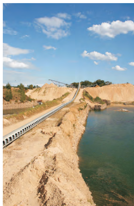
Bandes transporteuses du concasseur primaire vers les installations secondaires
