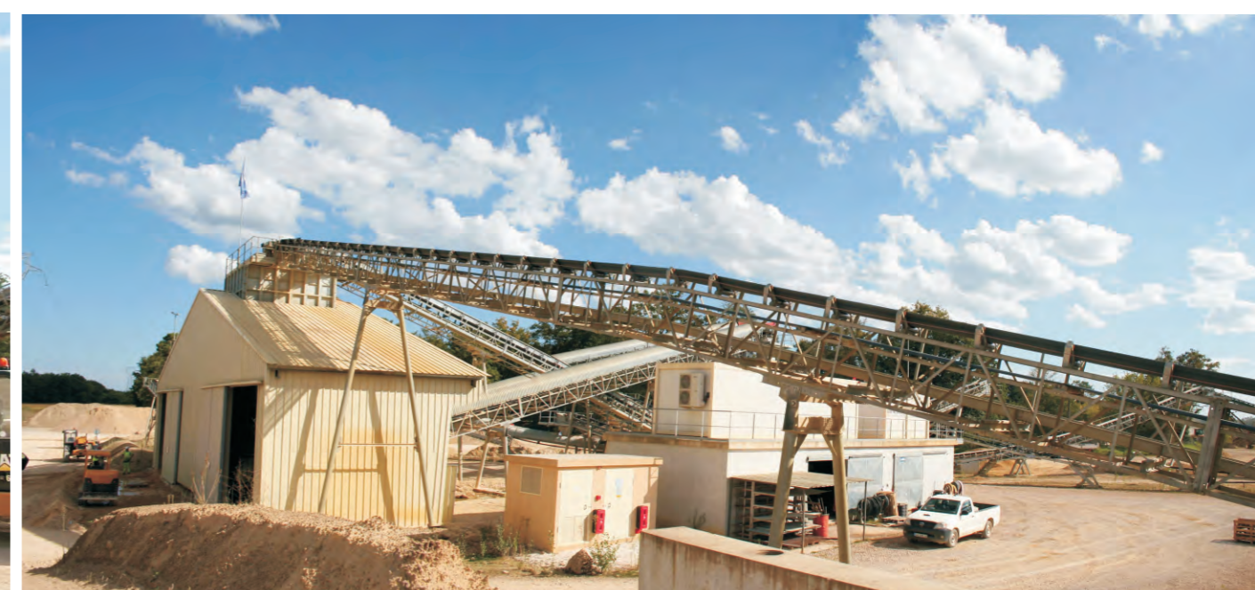
Bâtiment du concasseur secondaire
