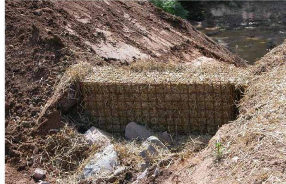
**Exemple de filtre à paille en sortie de bassin provisoire**
