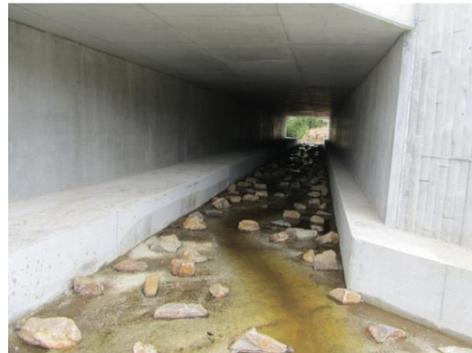
**Exemple d'ouvrage hydraulique avec banquettes**
