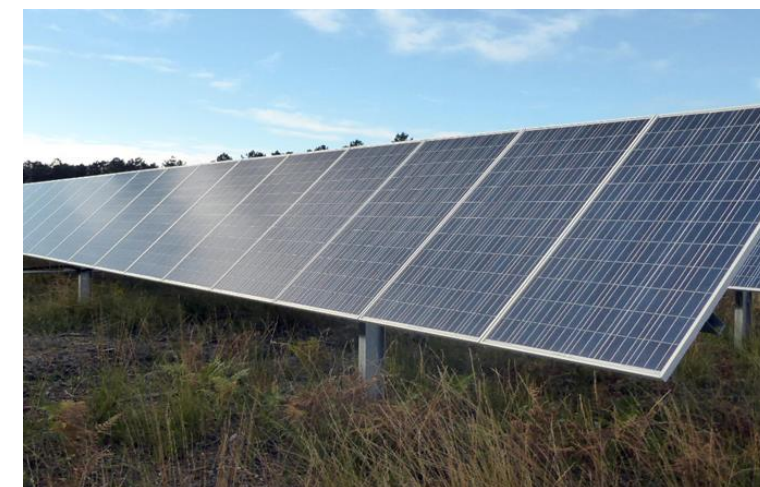
Figure 92 : Illustration de structures fixes sur pieux (source : URBASOLAR, 2018)
