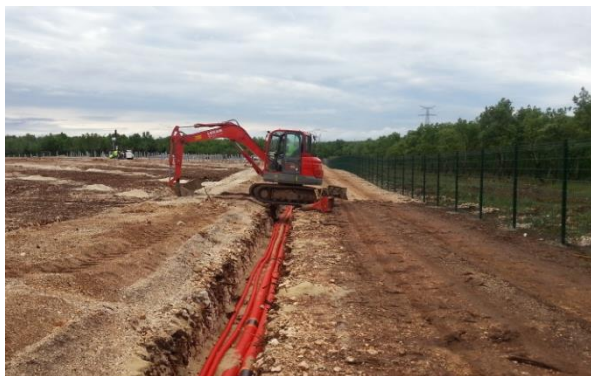
Figure 106 : Illustration d'enfouissement de réseau électrique (source : URBASOLAR, 2017)
