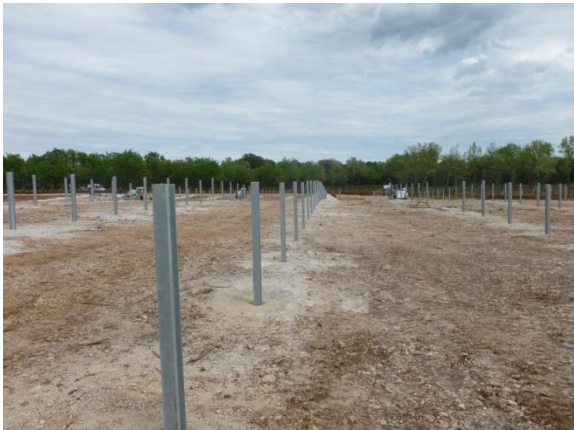
Figure 107 : Illustration de la phase de fixation des pieux battus (source : URBASOLAR, 2017)
