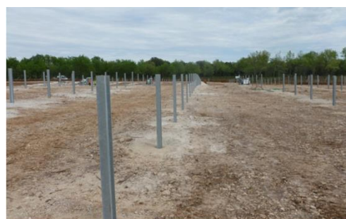
Figure 93 : Illustration du type d'ancrage au sol (source : URBASOLAR, 2018)
