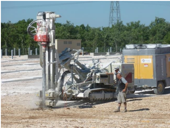
Figure 107 : Illustration de la phase de fixation des pieux battus (source : URBASOLAR, 2017)
