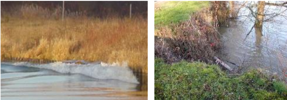
Figure 64 : Vague générée par une embarcation et érosion provoquée par le batillage
