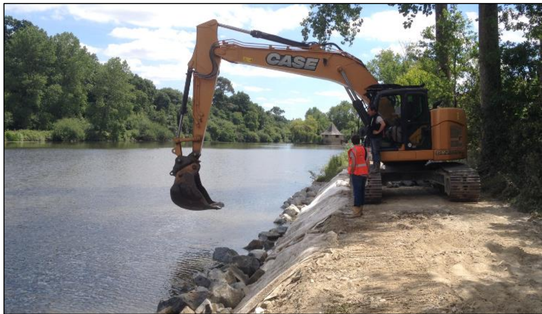
Figure 14 : Reconstitution de berge, avec réemploi partiel de sédiment – la Vilaine, Région Bretagne (IDRA, 2015)
