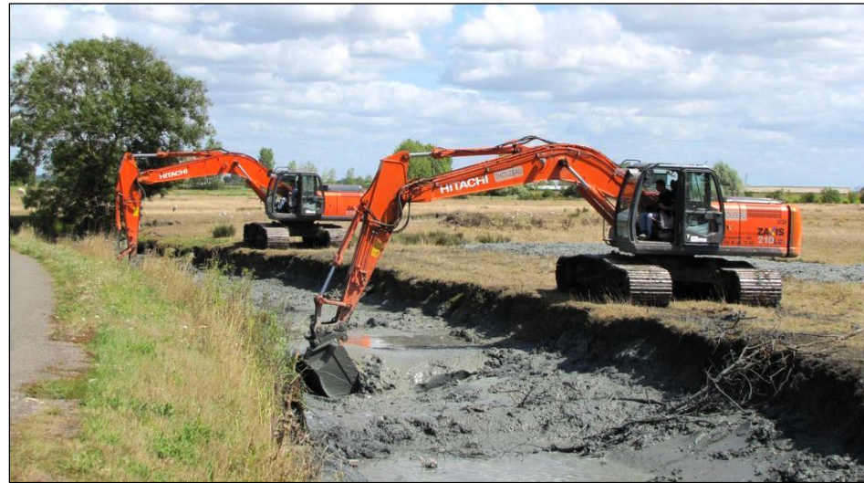
Figure 4 : Exemple de curage à sec
