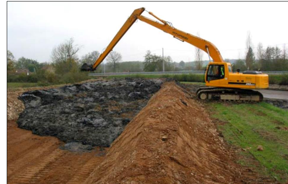
Figure 24 : Exemple de retournement dynamique des sédiments avant reprise (IDRA)
