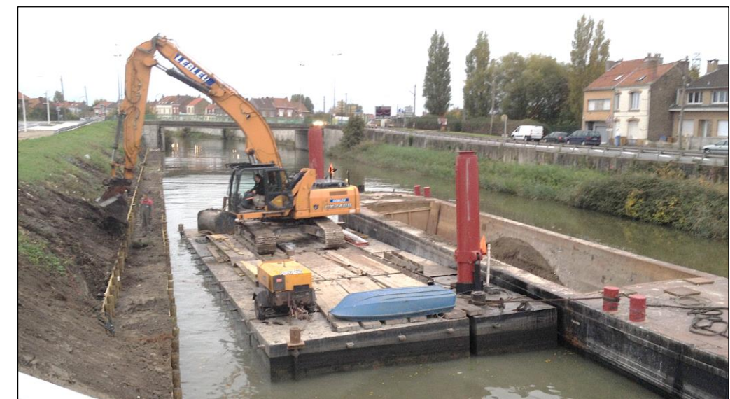
Figure 13 : Reconstitution de berge, avec réemploi de sédiment – (Dunkerque/photo IDRA)
