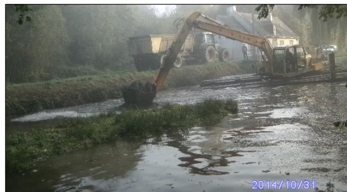
Figure 7 : Exemple de chargement direct des camions par les pelles sur pontons
