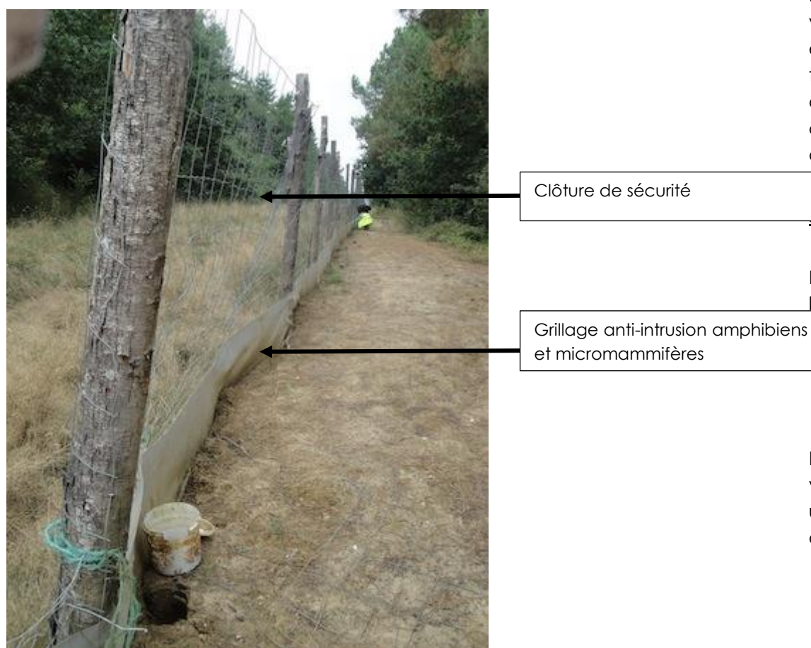
Figure 65 : Exemple de culture de sécurité couplée à un grillage anti-intrusion
