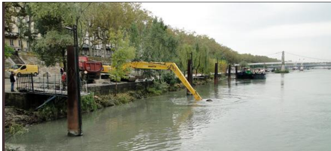
Figure 5 : Exemple de dragage mécanique à partir d'une berge
