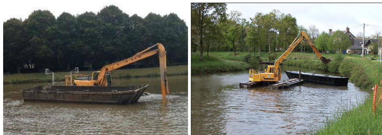
Figure 3 : Exemple d'atelier Dipper (ponton-pelle) et de pelle amphibie avec chargement de barge (photo IDRA Environnement et Région Bretagne)
