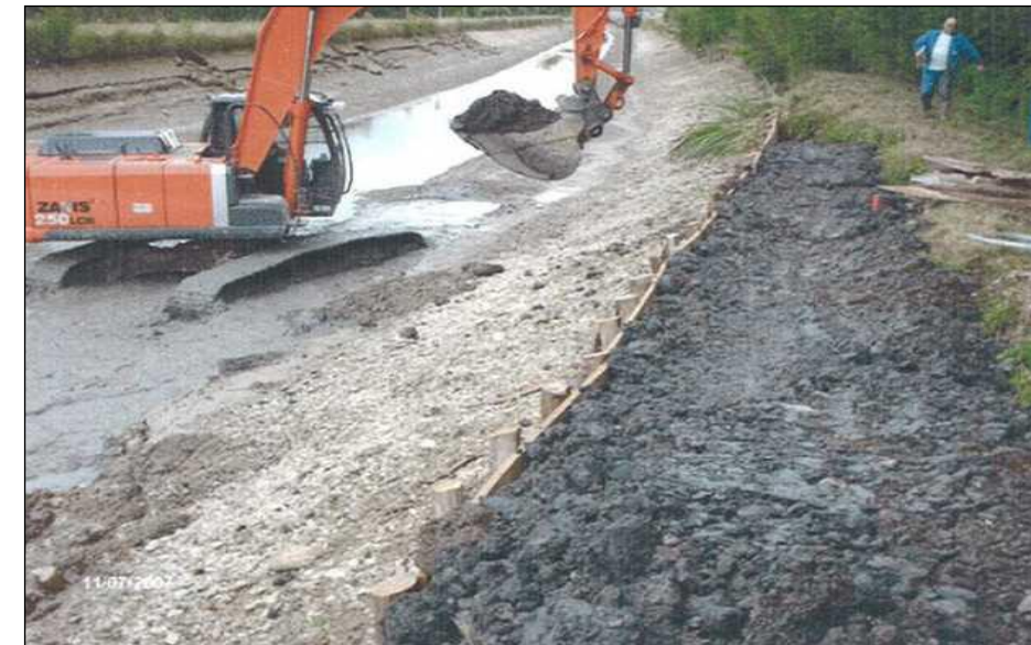
Figure 12 : Mise en œuvre de confortement avec palplanches (CETMEF - 2010)
