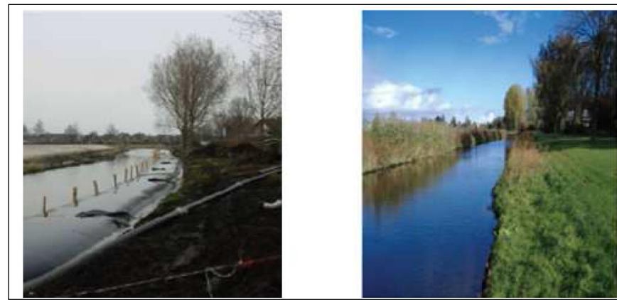
Figure 10 : Géocontainers pendant et après remplissage
