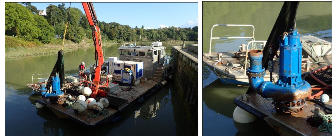
Figure 6 : Exemple de dragage par aspiration et redistribution au fil de l'eau (IDRA/EDF/OTS)
