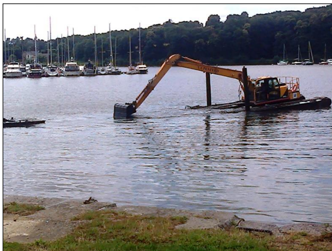
Figure 9 : Exemple du chantier de dragage par nivellement au lieu-dit Châtelier (Région Bretagne)
