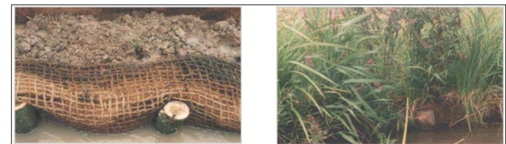
Figure 16 : Exemple de réalisation de fascine d'hélophytes (Agence de l'Eau)
