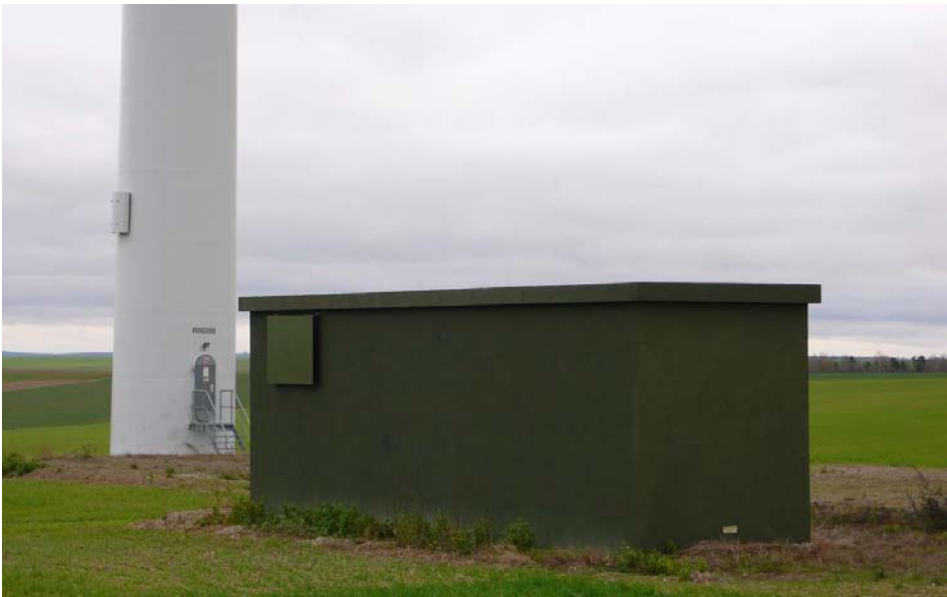
Figure 4 : Exemple de poste de livraison pour le projet
