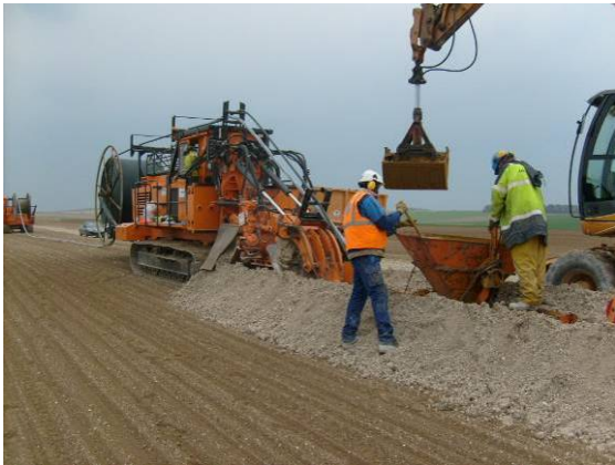
Figure 9 : Utilisation d'une trancheuse pour l'enfouissement des câbles électriques
