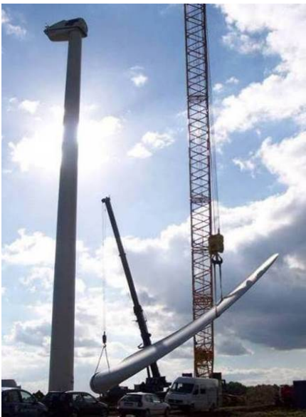
Figure 7 : Grue de montage et élevage du rotor
