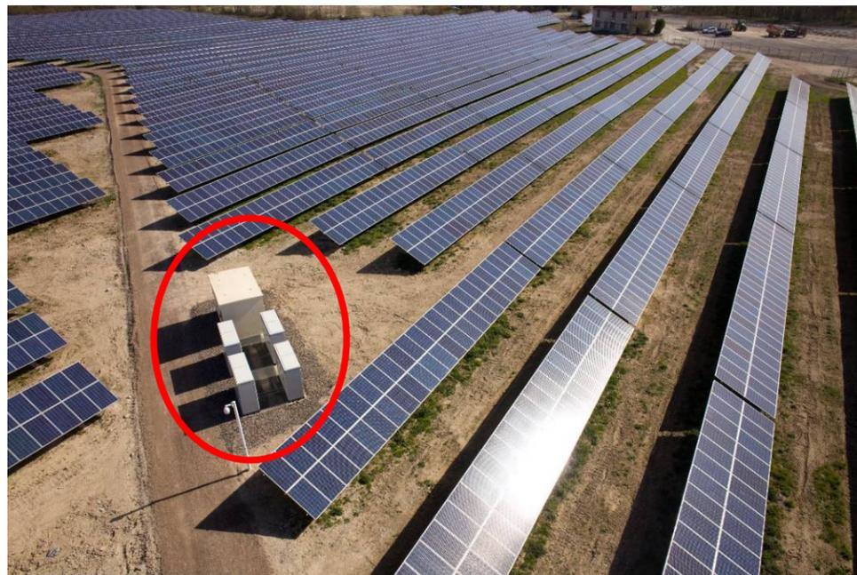
Photo 51 : Vue des onduleurs<sup>7</sup> et du poste de transformation (Source : Centrale solaire de Béthenville, QUADRAN)
