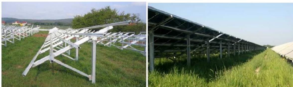
Photo 47 : Structures métalliques avant et après installation des modules photovoltaïques (Source : QUADRAN)
