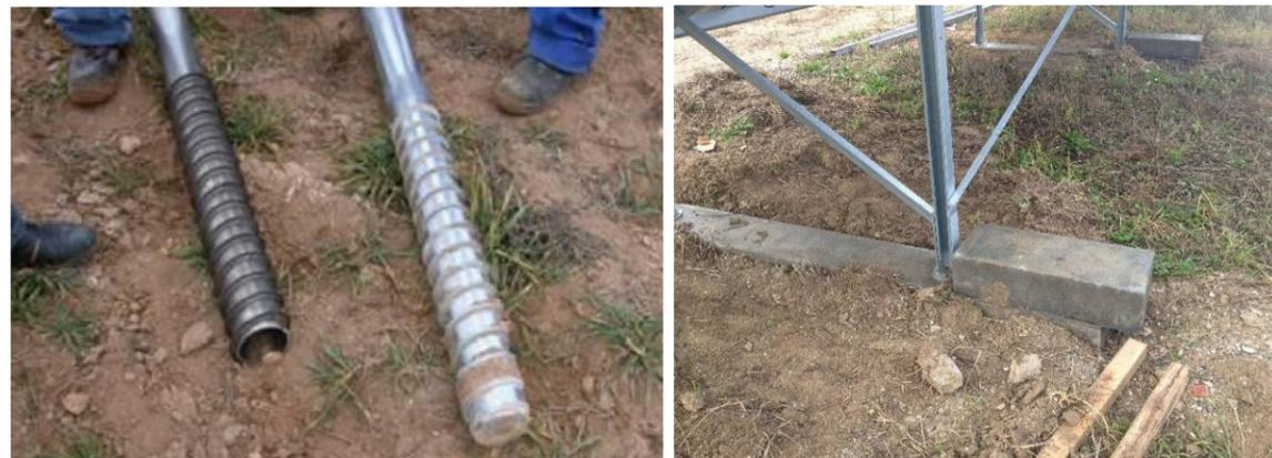
Photo 46 : Exemples de pieux vissés et de longrines bétons (Source : QUADRAN)
