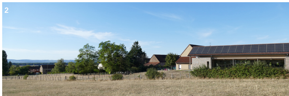
2 La forme et les dimensions des nouveaux bâtiments s'inspirent du patrimoine bâti proche afin de favoriser l'inscription paysagère de l'opération dans le tissu villageois.
