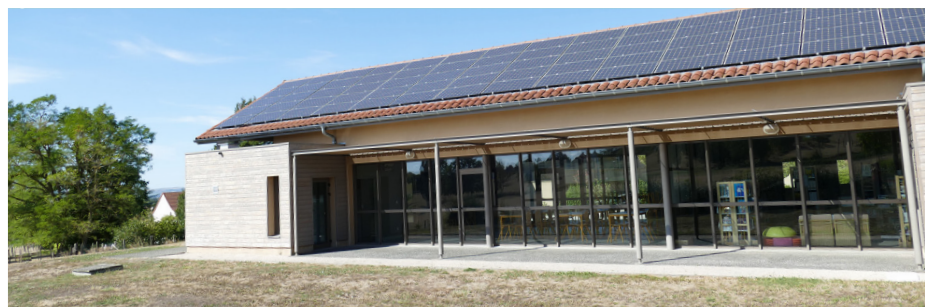
Panneaux photovoltaïques disposés sur le toit de la salle communale et de la bibliothèque.
