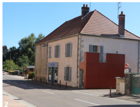
3 Réhabilitation du bâtiment en front de rue sur la route départementale, local commercial en rez-de-chaussée
