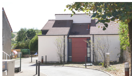
1 Une voie apaisée a été aménagée desservant à la fois les deux pavillons et les trois logements à ossature bois, attenants à la dent creuse.
