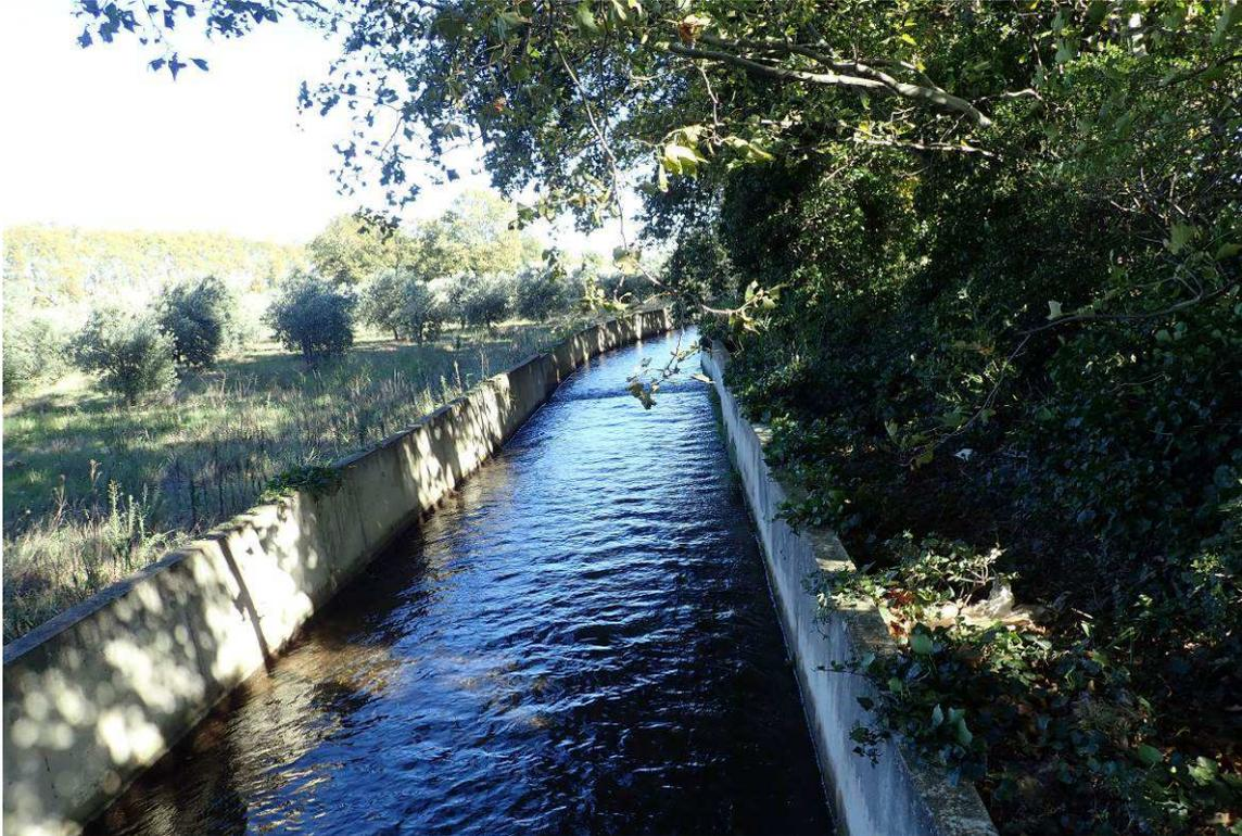
*Section type en amont du cuvelage. Le développement de la végétation en rive droite est trop proche du canal*
