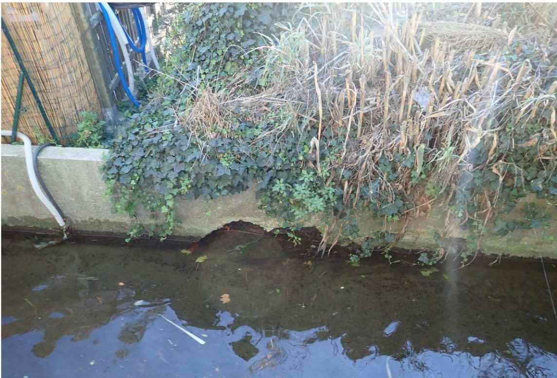
*Dégradation du pied de bajoyer du cuvelage.*
