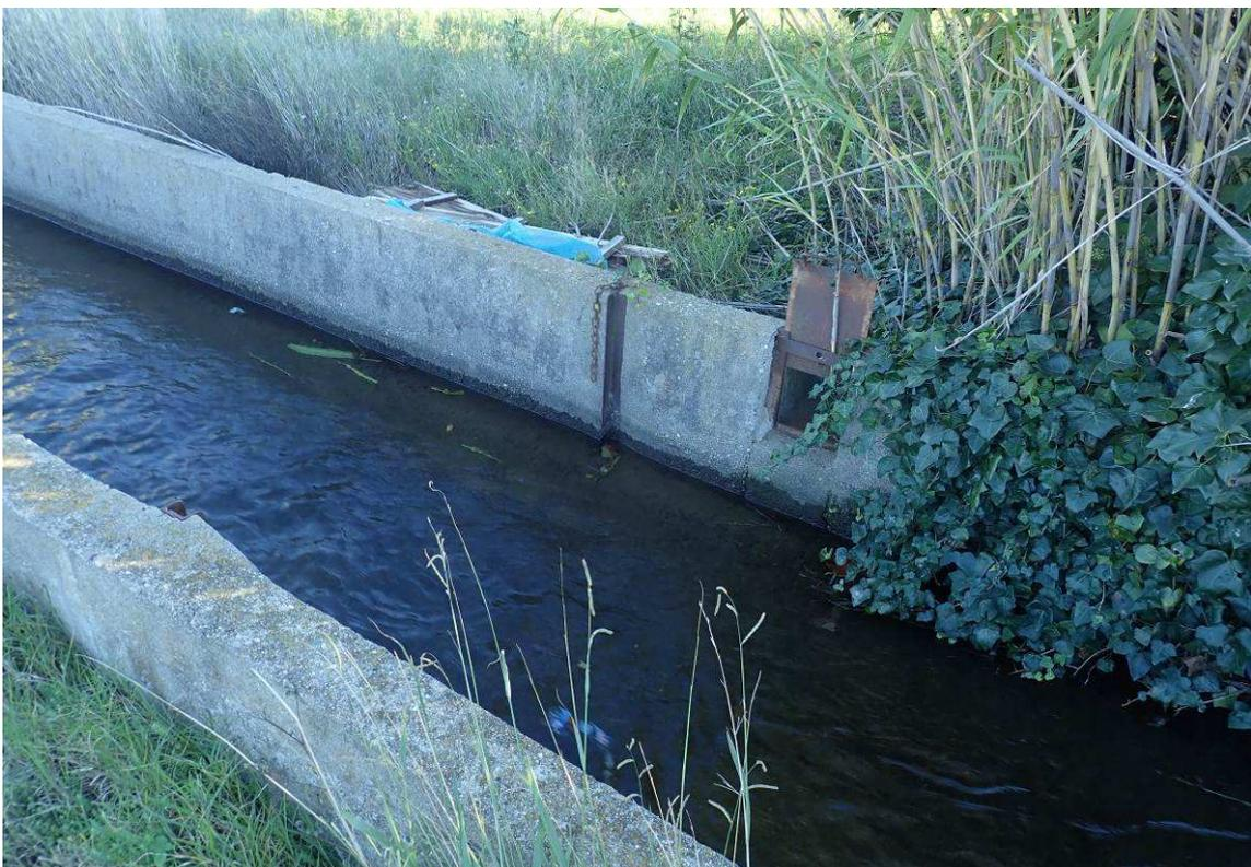
*Configuration type des prises d'eau dans la zone agricole aval. Des glissières permettent de disposer des planches pour relever la ligne d'eau et alimenter la martellière*
