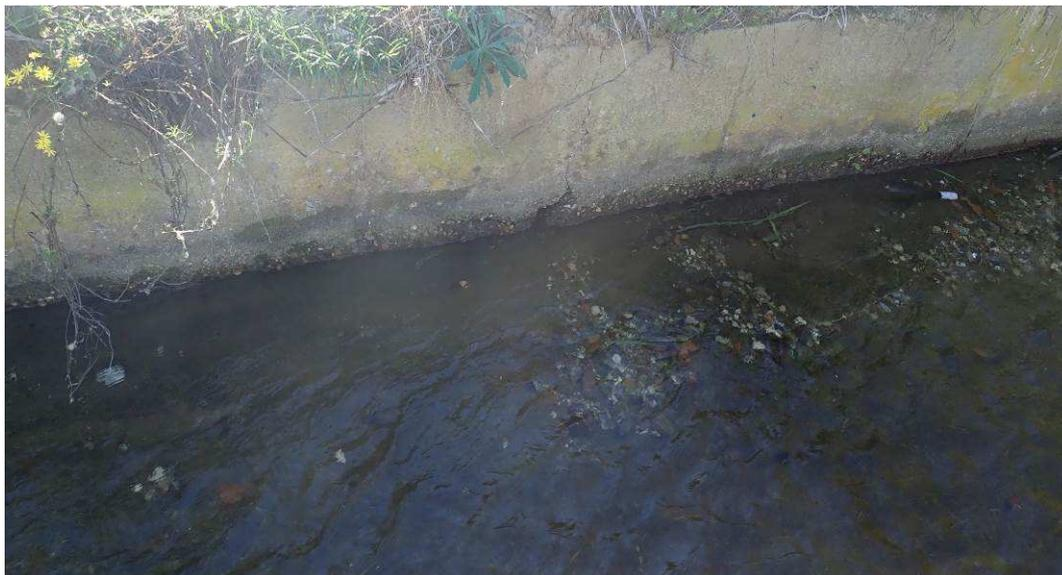
*Dégradation du béton et forte proportion de graviers en pied de canal*
