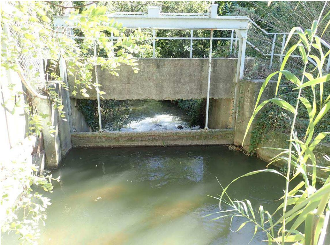
*Vanne de décharge permettant la régulation du prélèvement*
