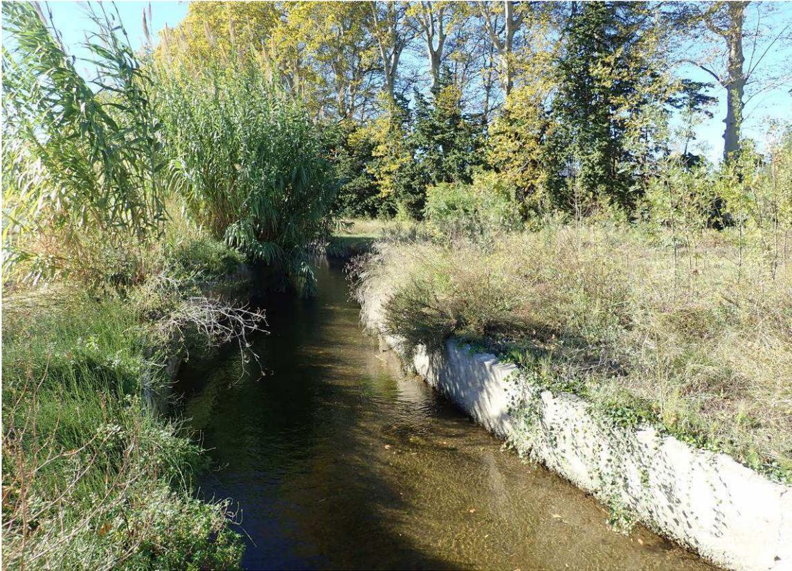
*Déstabilisation du mur rive gauche en amont de la vanne de décharge dans le ruisseau d'en Godall. Développement de cannes de Provence sur la rive droite*
