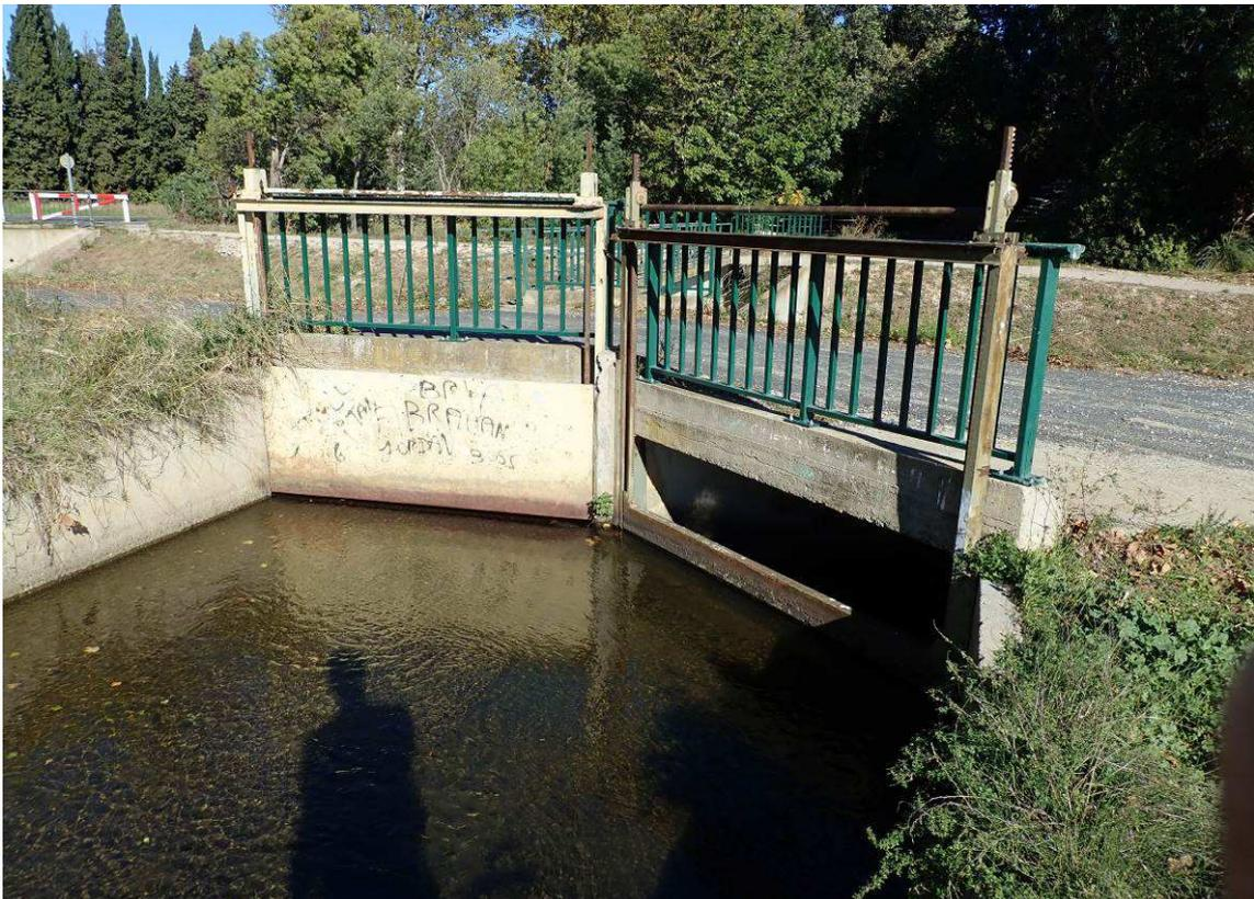
*Vanne de sectionnement et vanne de décharge dans le ruisseau d'en Godall*
