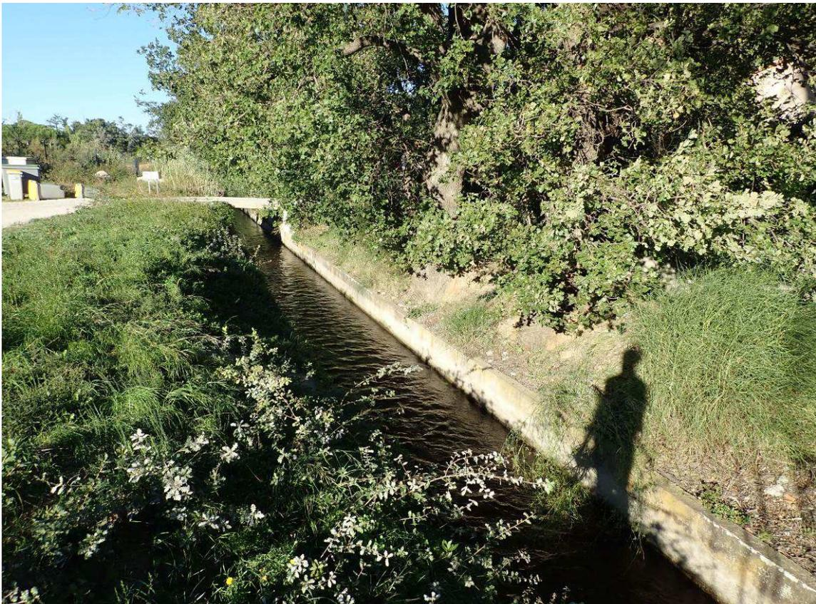
*Développement de chênes contre la paroi du canal en rive droite à l'aval du moulin*
