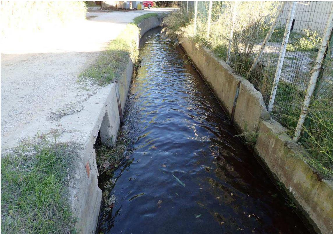
*Départ d'un secondaire non vanné. Clôture ne respectant pas la règle des 2m indiquées aux statuts en rive droite.*
