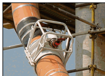
Mesure de pression sur canalisation
