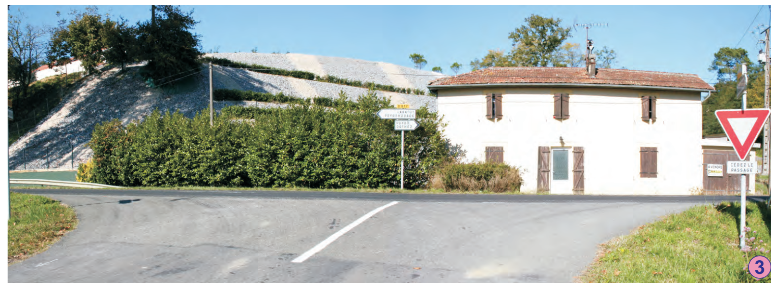
Signalisation à l'embranchement de la RD 103 avec la RD 817
