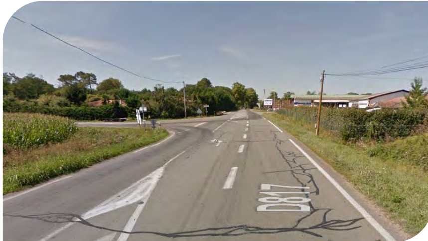
Carrefour de la RD 817 avec la RD 22 (Source : Google Maps)
