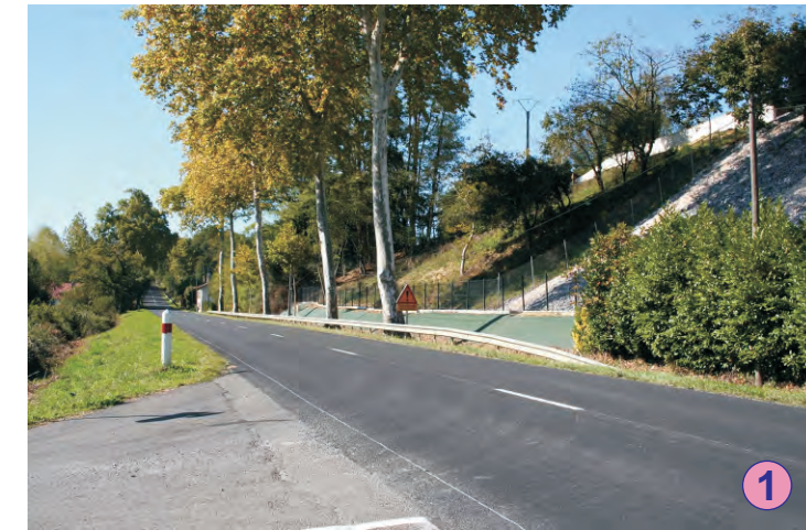
Vue sur la RD 817 à l'Ouest
