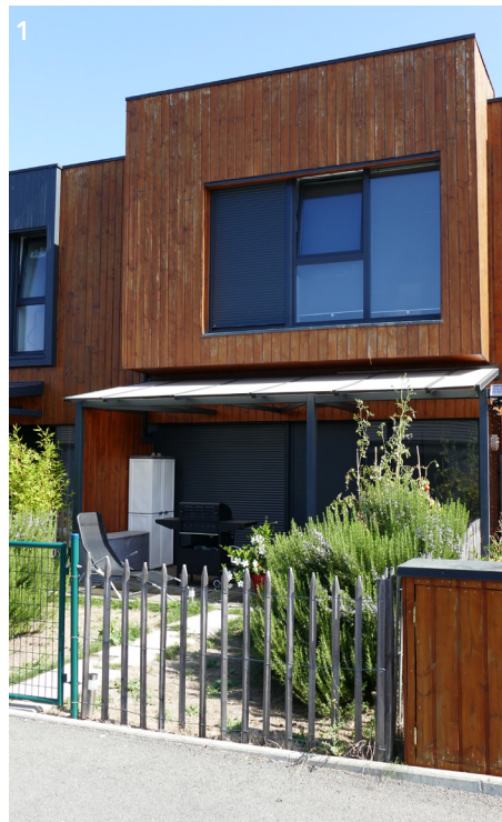
Frontage des logements : jardinets et terrasses orientés Est ou Ouest
