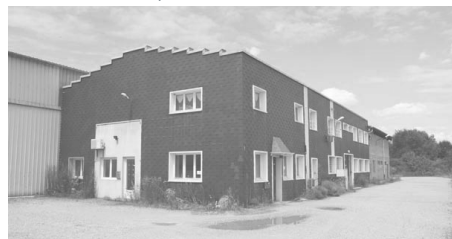
Site avant travaux (source : Rudy Toulotte)
