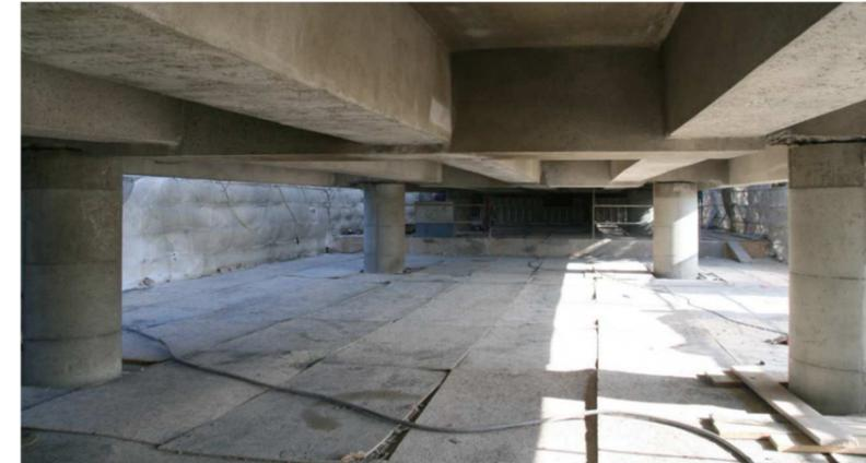
Figure 106 : Exemple de chantier d'hydrodémolition et reconstitution du béton d'enrobage - Pont de Kérisper (source CEREMA)
