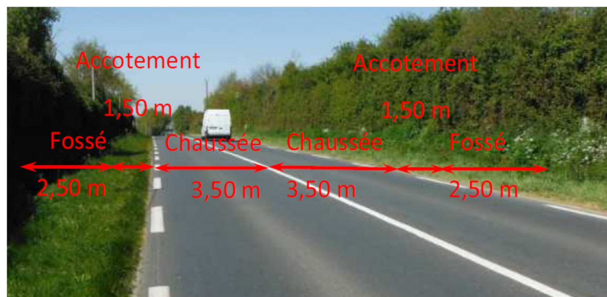
➤ Profil en Travers n°2 : RD 948 Profil déblais au lieu-dit « Le Fougerais »
