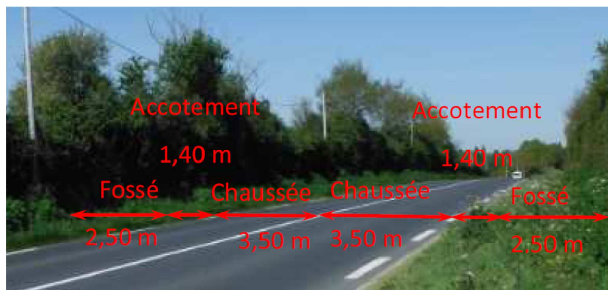
➤ Profil en Travers n°1 : RD 948 Profil remblais au lieu-dit « Sainte-Marie »
