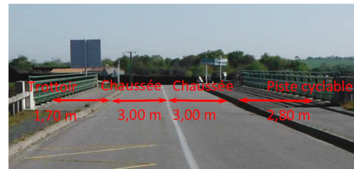
➤ Profil en Travers n°3 : RD 40 au niveau du pont de franchissement de la RD 948
