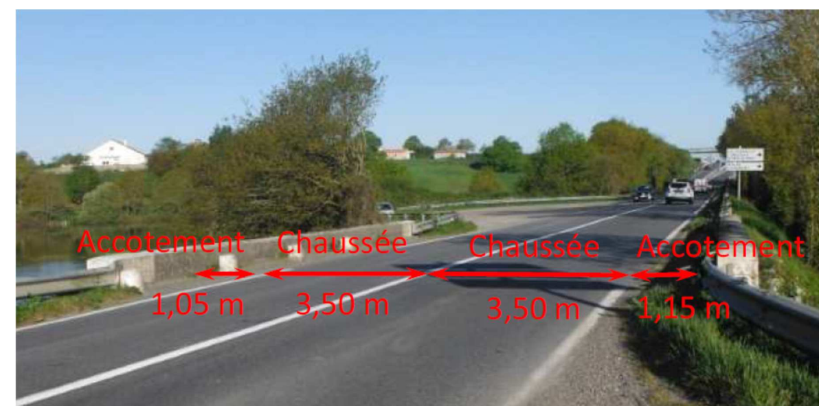
➤ Profil en Travers n°4 : RD 948 Franchissement du cours d'eau « La Vie »
