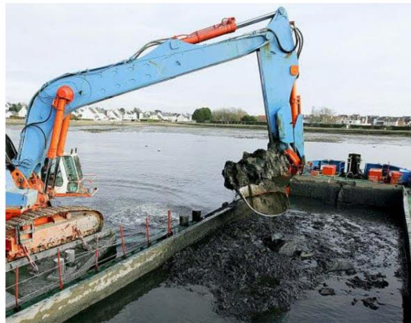
Photo 7 : Dragage mécanique et chargement dans un chaland
