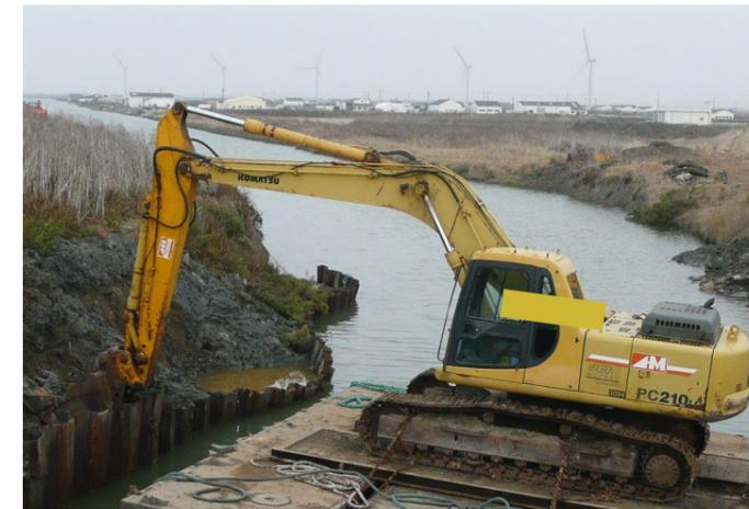
Photo 1: Pelle sur ponton pour travaux sur berge
