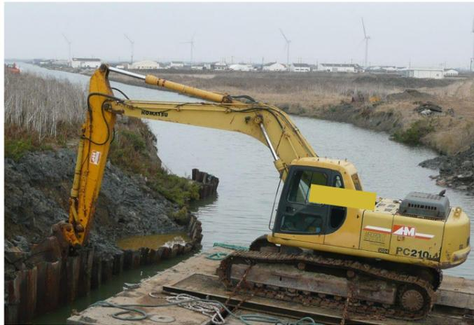
Photo 8: Pelle sur ponton pour travaux sur berge
