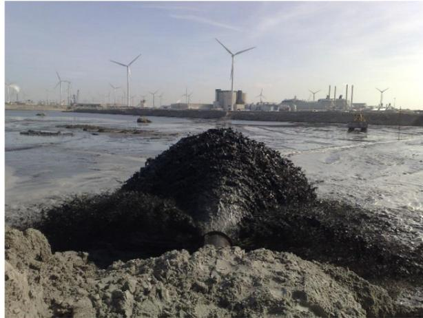
Photo 6 : Refoulement des matériaux dans une chambre de stockage
