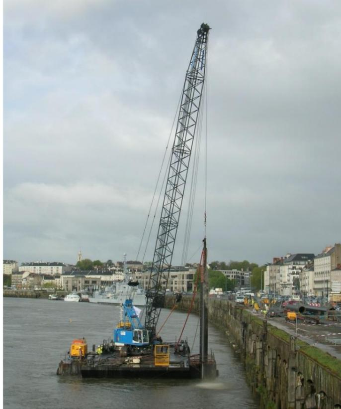
Photo 2 : Exemple de grue et de barge mobilisée pour les travaux du ponton Belém à Nantes (MOE SCE)
