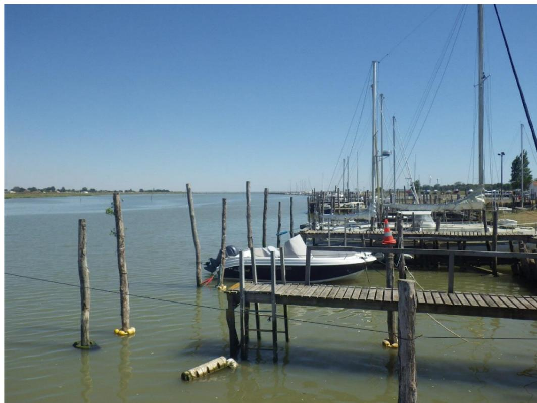
**Figure 73 : Estacades verticales et pontons en bois**
