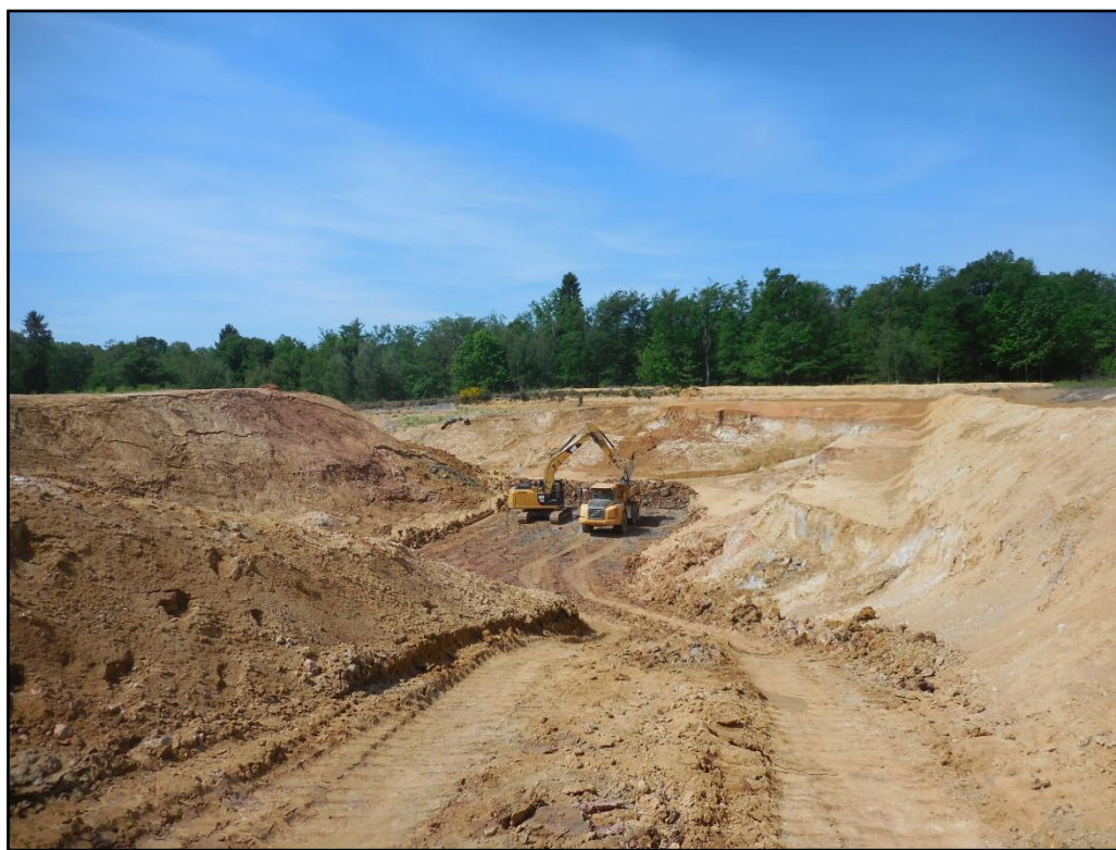
Photographie 1 : Extraction des matériaux
