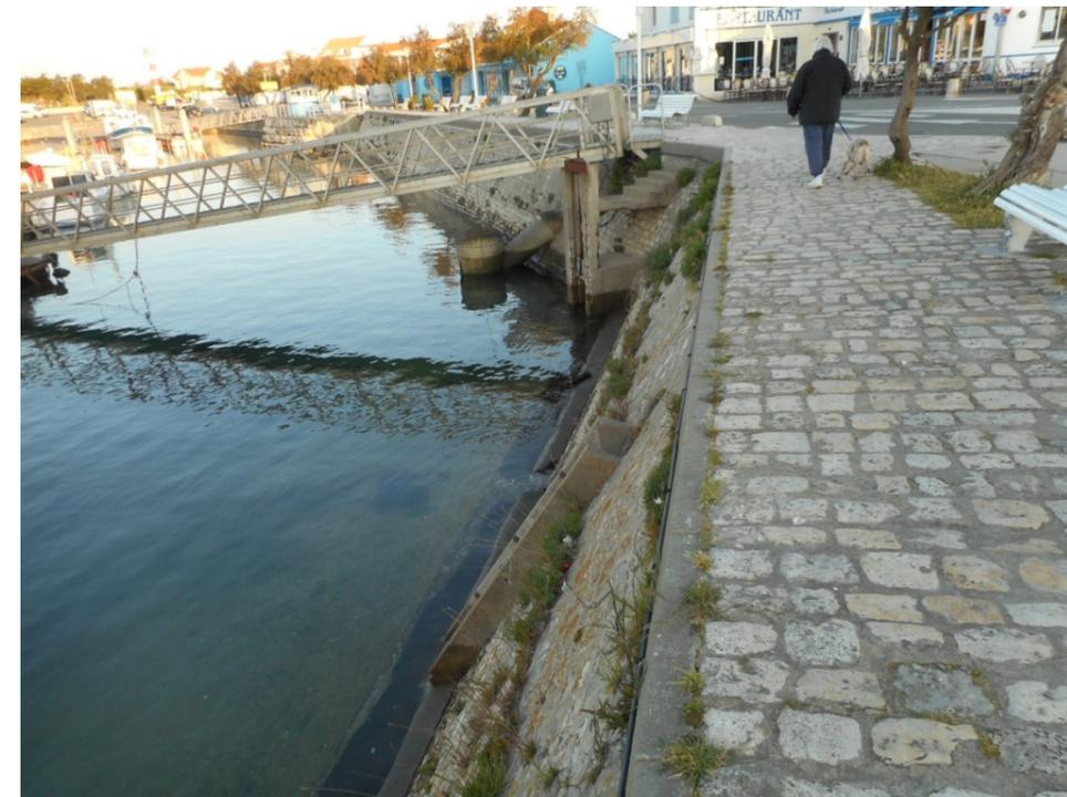
**Photo 4 – Exutoire de rejet des eaux pluviales du bassin versant urbain de La Cotinière (source : CD17)**
