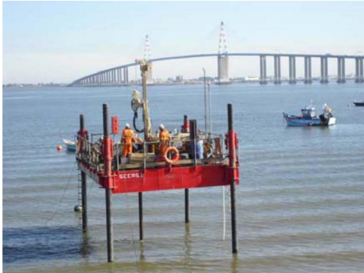
**Figure 7 – Plateforme autoélévatrice ayant servi pour la réalisation des sondages carottés (source : VINCI)**
