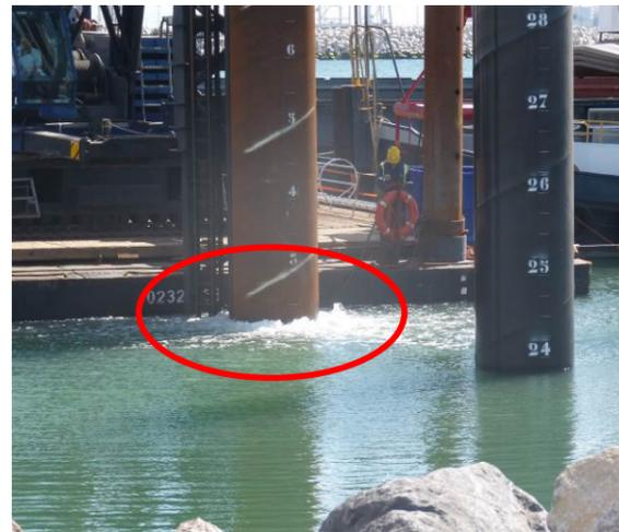
**Photo 5 - Exemple de rideau à bulle en fonctionnement lors du battage**
