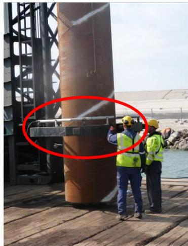
**Photo 4 - Exemple de rideau à bulle hors d'eau en place autour du tube à mettre en fiche**
