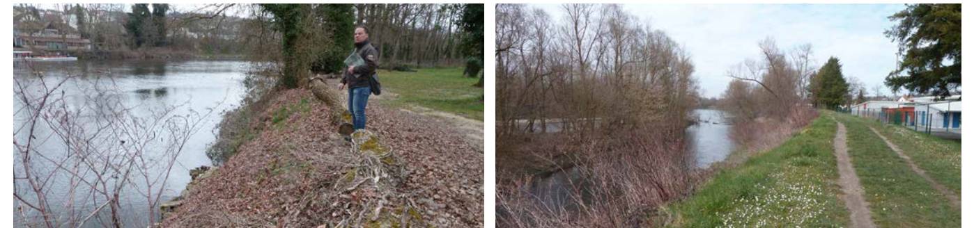
Figure 69 Vues de tronçons constitués en remblai en rive de l'Allier. (Images Biotec, mars 2016). Image de gauche: secteur de remblai situé au droit d'une ancienne zone de camping. Image de droite : secteur de remblai sous la forme d'une digue au droit d'un camping et d'infrastructures sportives.
