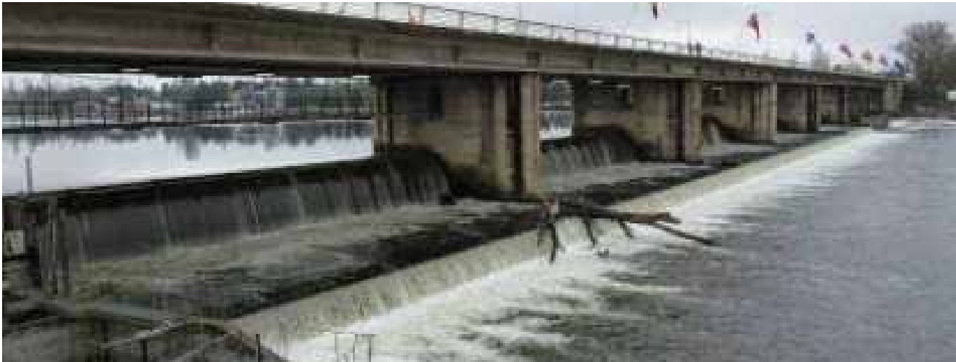
Figure 23 Photo du pont de l'Europe (pont barrage de Vichy) et de l'ouvrage constitué de sept vannes-clapets métalliques faisant chacune 29,5 m de large et comprises entre des piles de 3 m et manœuvrées par un dispositif à moteurs électriques.
