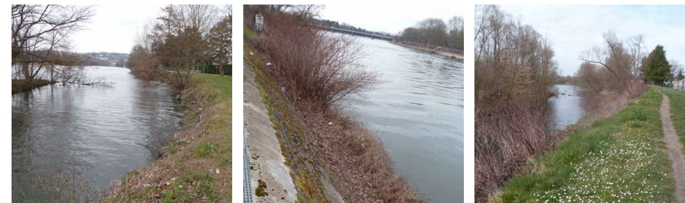
Figure 2 Vues des secteurs d'enrochement en rives de l'Allier, de secteur de remblai sous la forme d'une digue au droit d'un camping et d'infrastructures sportives, et de de perrés constitués de pierres maçonnées
