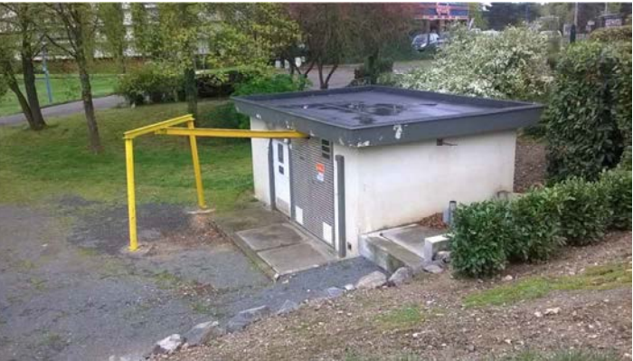
Figure 147 Station de refoulement de Bellerive sur Allier. Le bâtiment abrite également un poste de transformation (Source : ARTELIA 2016).
