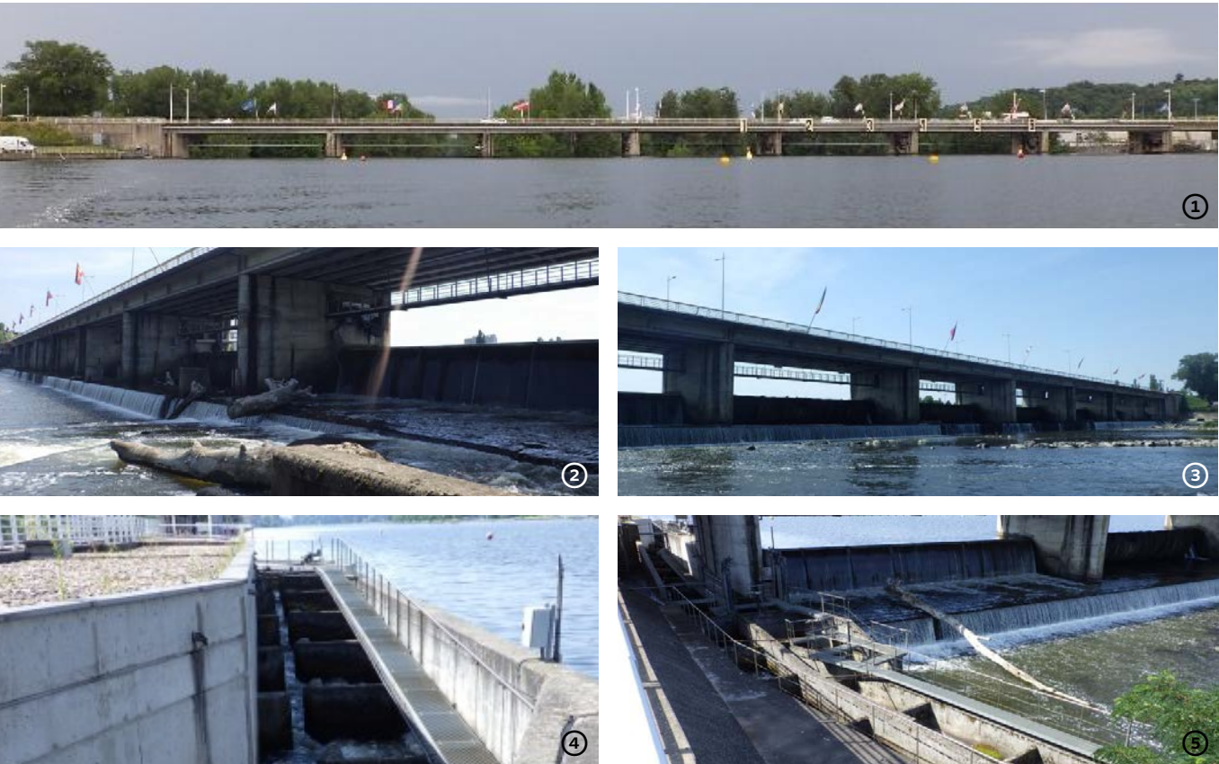
Figure 20 Illustration de barrage permettant la retenue du Lac d'Allier : 1 - Vue d'ensemble du barrage et du pont de l'Europe; 2 -Élévation aval depuis la rive gauche; 3 -Élévation aval depuis la rive droite; 4 - Passe à poissons, vue vers l'amont en rive droite; 5 - Passe à poissons, vue aval en rive droite (Source : SATIF 2017).
