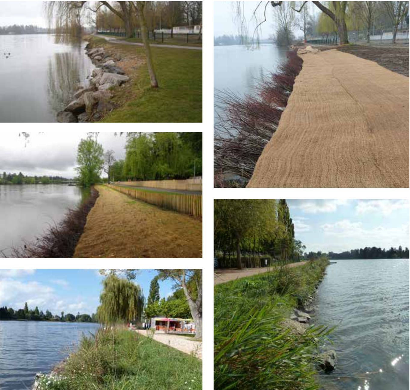
Figure 7 Exemple d'opération identique : décorrection puis réaménagement en technique mixte de la berge droite de l'Allier sur le site des plages de Vichy – Conception, photos et maîtrise d'œuvre : ingénieurs du bureau Biotec en assistance au bureau Axe Saône mandataire.
