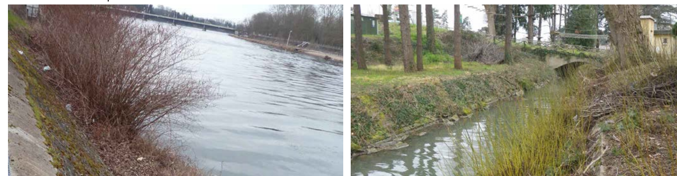
Figure 67 Vues des secteurs de perrés constitués de pierres maçonnées situés en rive de l'Allier ainsi qu'en bordure du Sarmon. (Images Biotec, mars 2016). Illustrations de gauche : perrés en rive gauche faisant office de soutènement de voirie, aujourd'hui relativement dégradés et colonisés par les espèces invasives telles que la Renouée du Japon. Illustration de droite : perrés en rives du Sarmon infestés par une autre espèce invasive, le Ptérocaryer du Caucase.
