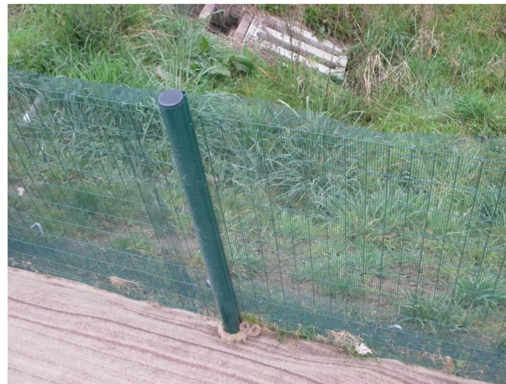
Treillis amphibien installé sur une barrière petite faune, ETEN ©
