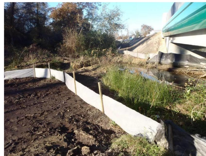
**Implantation de barrières amphibies en géotextile permettant d'éviter les déplacements des individus du cours d'eau vers le chantier ETEN ©**
