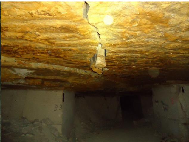
*Illustration 20: Exemple de fracturation du toit de galerie. Source : rapport BRGM 2016*
