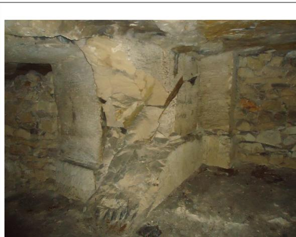
*Illustration 6: Exemple de pilier de la carrière affecté par une fracture
