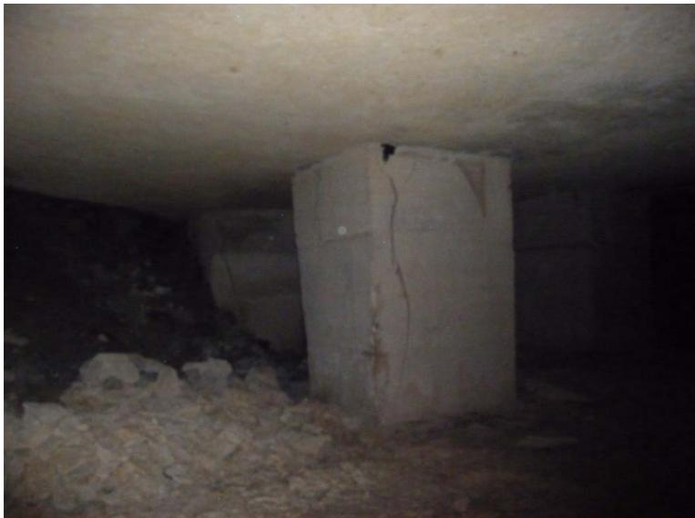
*Illustration 12: Pilier fracturé dans le secteur des Auvions.
