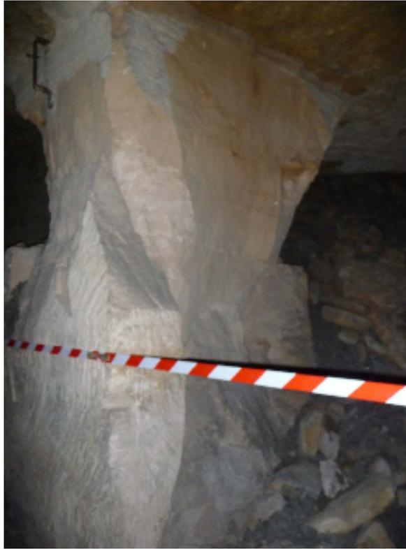
*Illustration 13: Pilier fracturé en forme de diabolo au bord de l'effondrement des Auvions. Source : rapport BRGM 2016*
