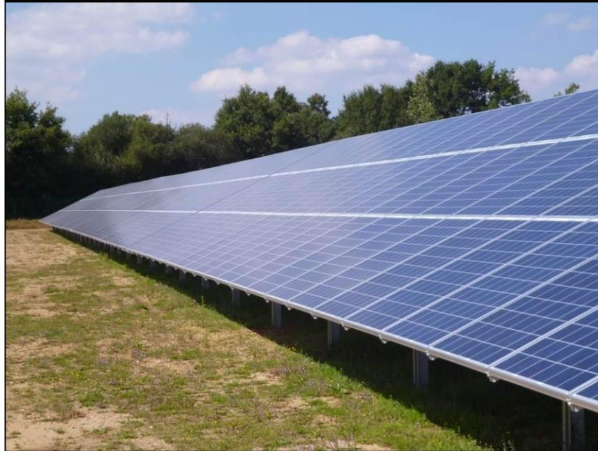
Figure 11 : Exemples de champs solaires panneaux fixes et pieux battus
