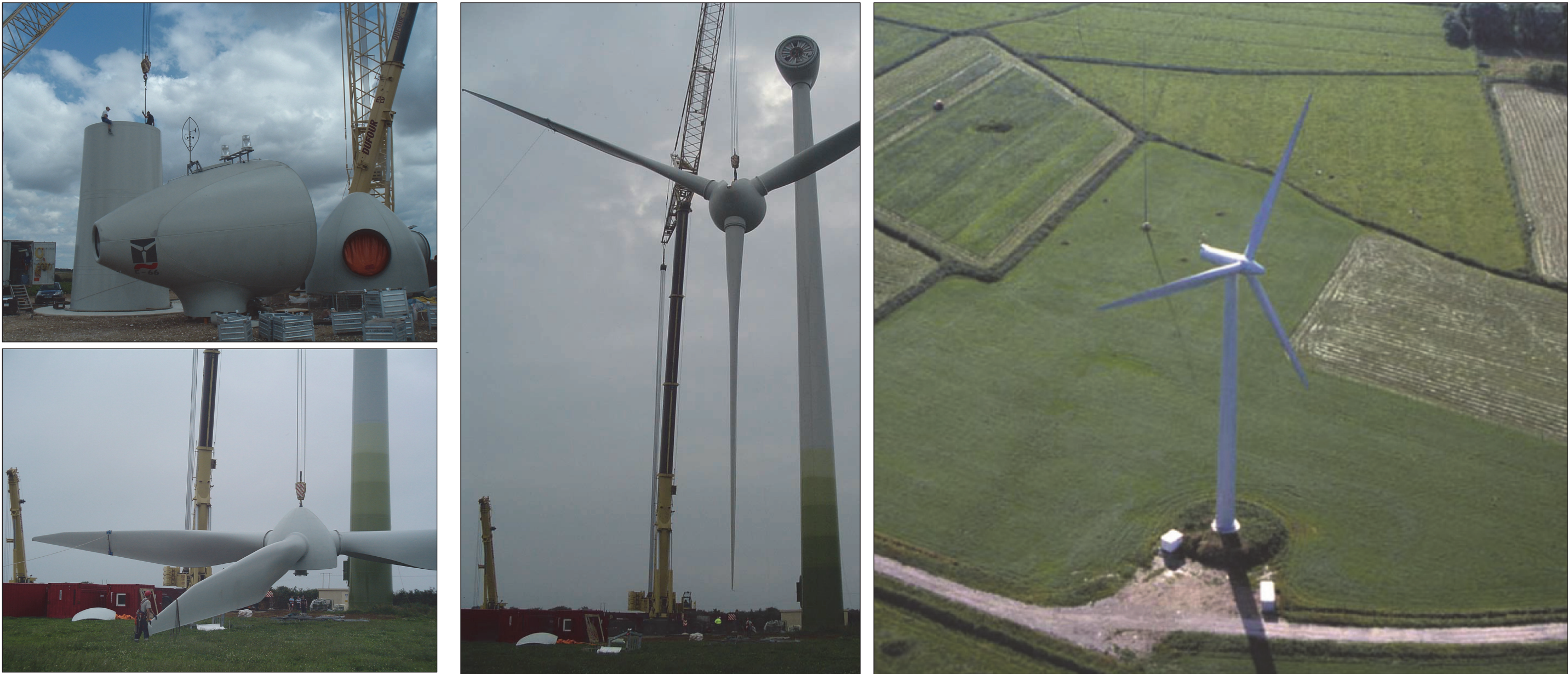
Montage et levage du rotor
