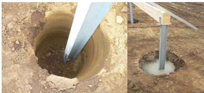
*Photographie VII-1 : Réalisation de fondations béton superficielles pour ancrage des structures*
