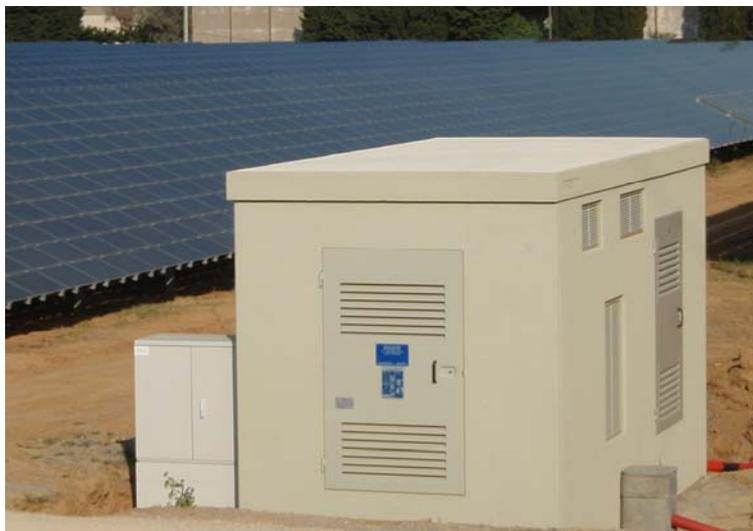
*Photographie IV-3 : Exemple d'un local de conversion d'énergie*
