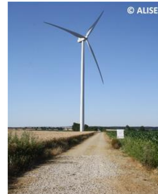
Photo 2 : Exemple de piste d'accès aux éoliennes
