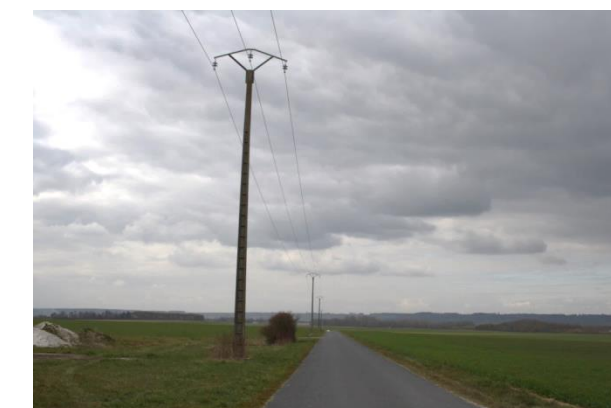
Photo 22 : Route communale RC n°1 traversant la ZIP
