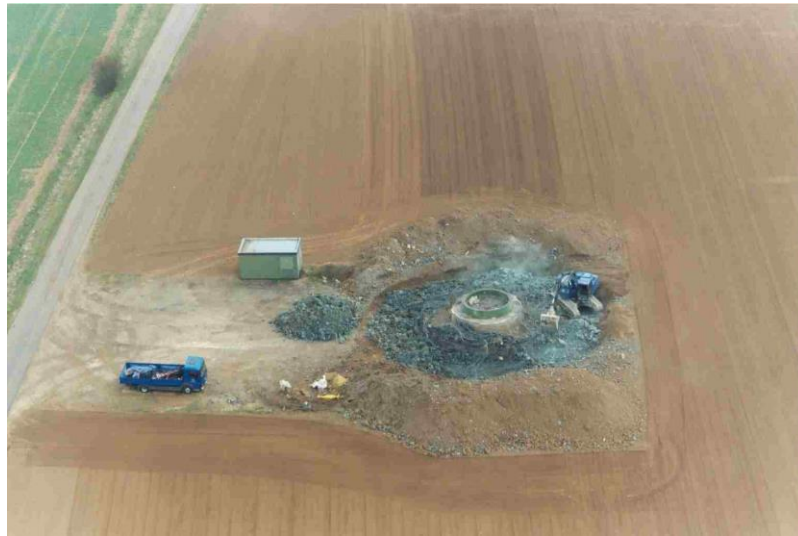
Photo 46 : Exemple de démontage de la plateforme et des fondations d'une éolienne
