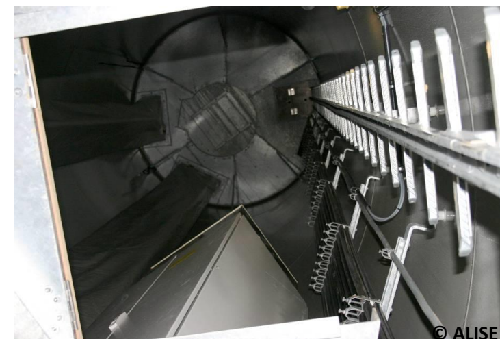
Photo 48 : Intérieur du mât d'une éolienne (échelle d'accès)
