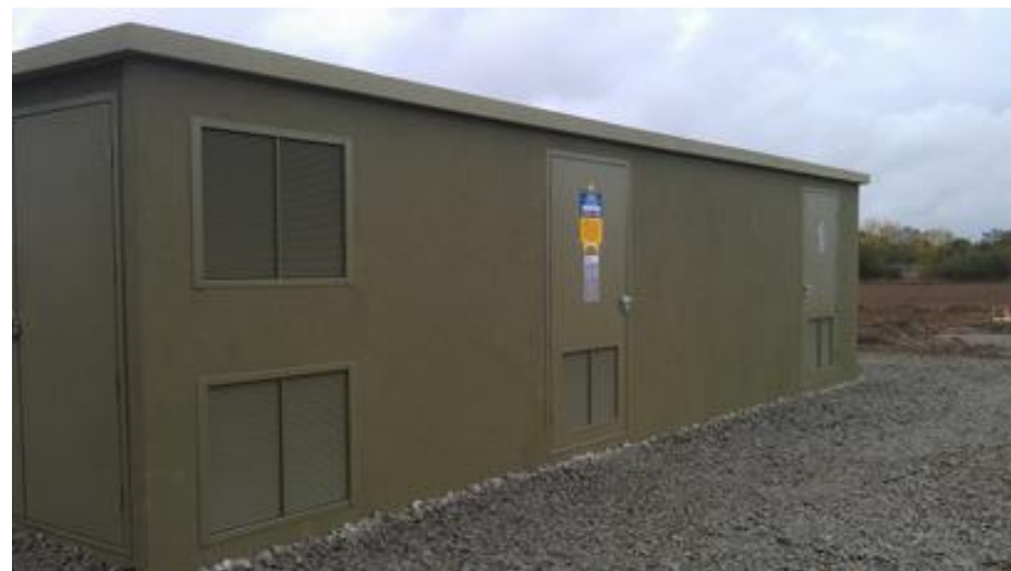
Photo 10 : Illustration d'un exemple de poste de livraison
