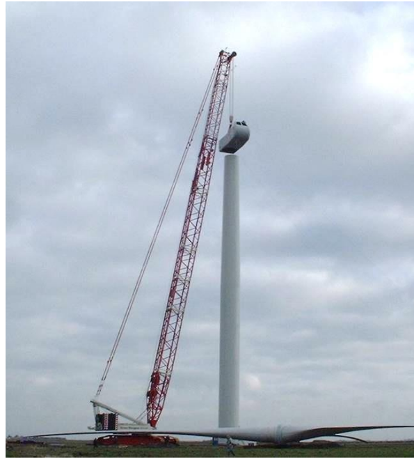
Photo 8 : Installation de la nacelle
