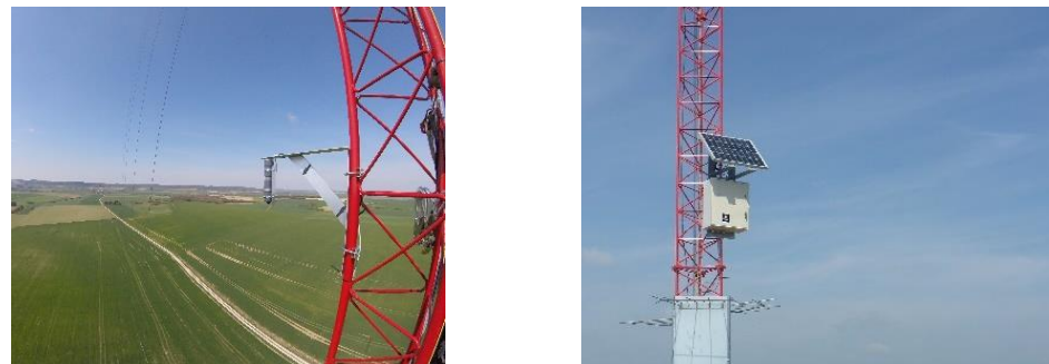
Figure 189 : Illustrations d'un microphone avec la protection du microphone et d'un boîtier avec panneau solaire.
