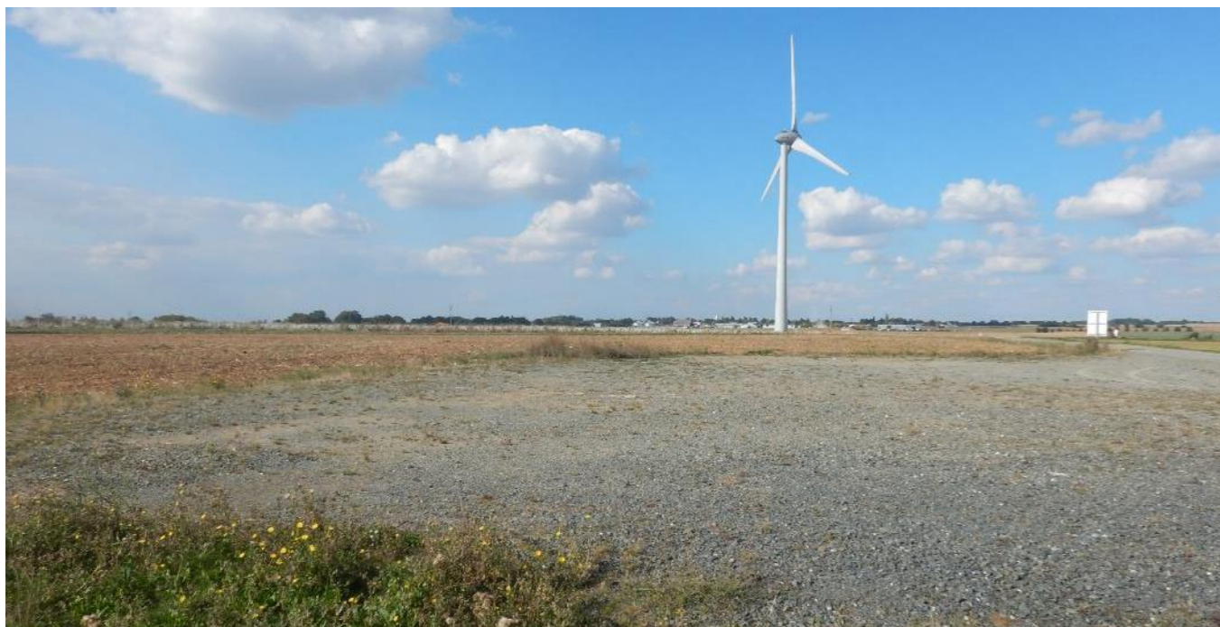
Photo 3 : Exemple d'aire de grutage depuis le pied d'une éolienne
