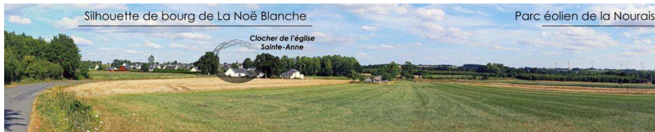
Photo 98 : Découverte de l'église Sainte-Anne de La Noë-Blanche et de son clocher, en arrivant via la RD52 au nord-ouest
