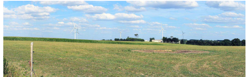
Photo 57 : Le parc éolien de la Nourais
