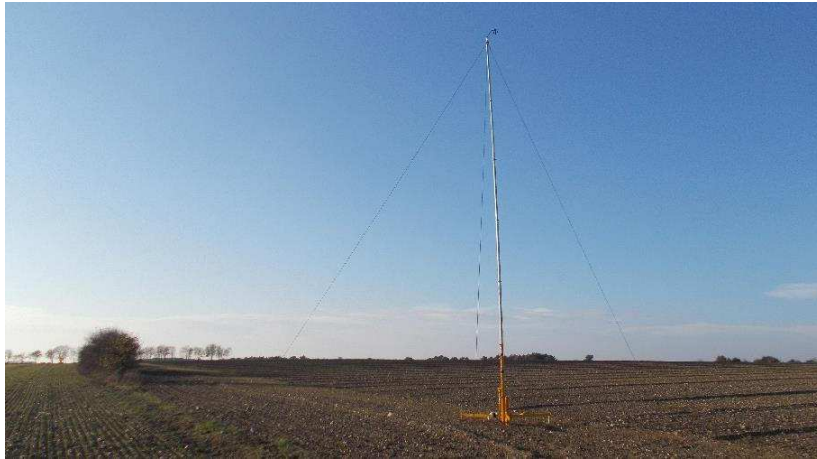
Photo 2 : Mât de mesure
