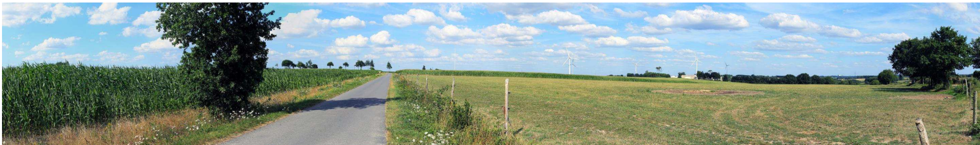
Photo 101 : Le parc éolien de la Nourais, une implantation de cinq éoliennes
