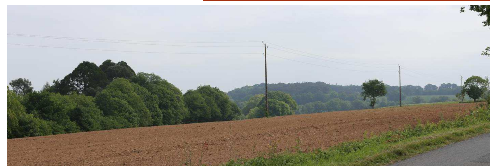
Photo 56 : La ligne électrique traversant la zone est
