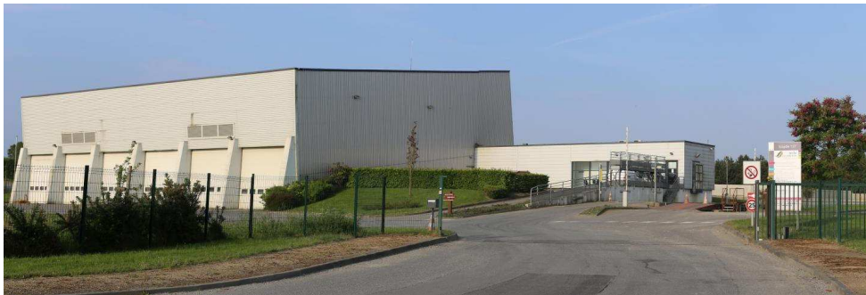
Photo 54 : SECHE ECO INDUSTRIE à 3,2 km de la zone d'implantation potentielle
