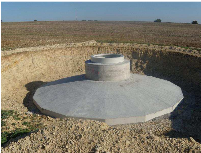
Photo 126 : Ferrailage et coulage d'une fondation d'éolienne
