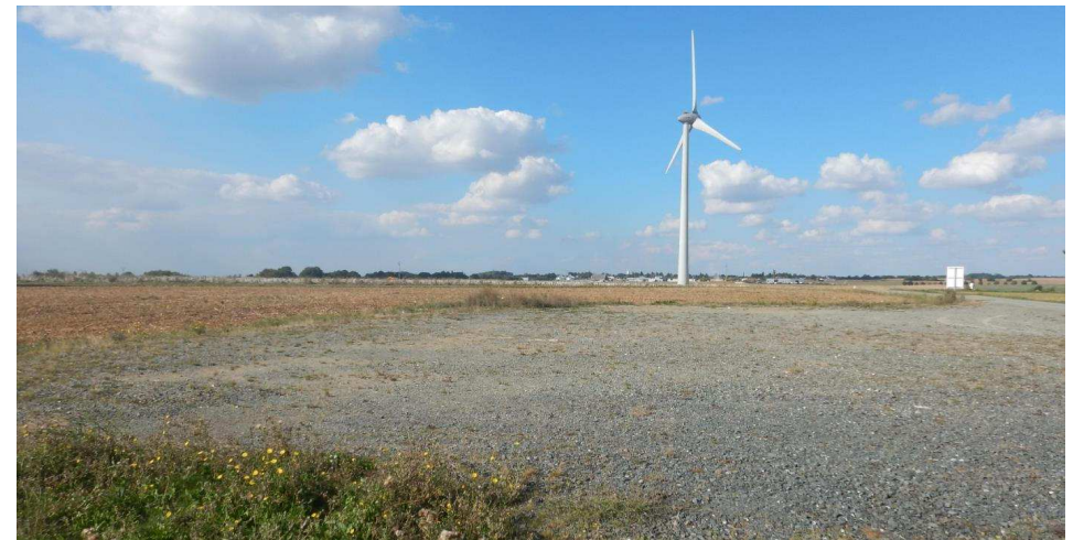
Photo 127 : Exemple d'aire de grutage depuis le pied d'une éolienne
