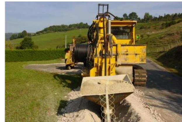
Photo 130 : La pose d'un câble souterrain depuis le poste de livraison jusqu'au réseau électrique public
