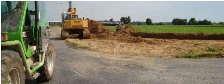
Photo 134 : les travaux de rectification d'un virage
