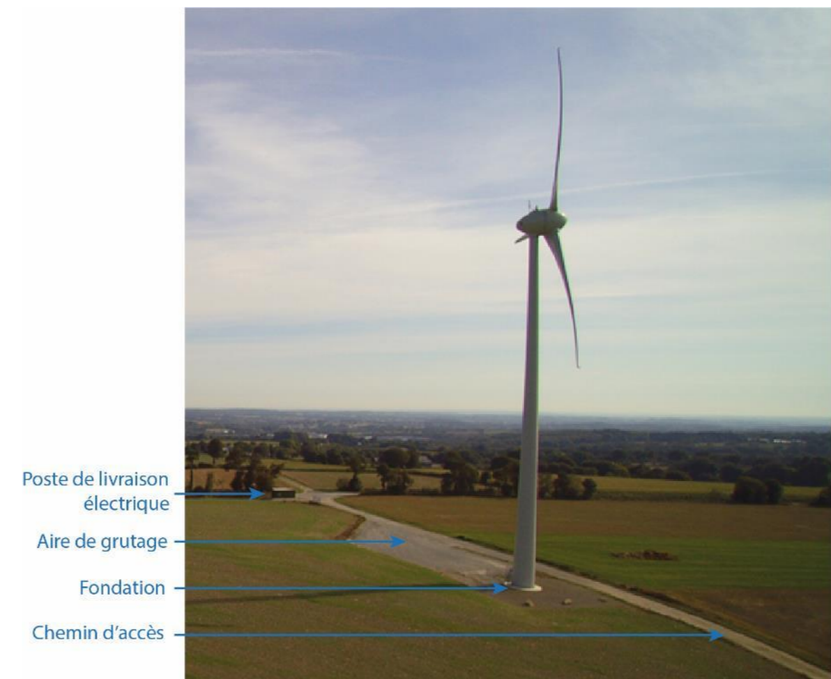
Figure 3 : Une éolienne et ses aménagements annexes (AEPE Gingko)
