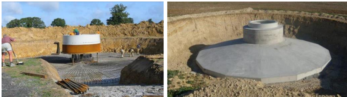
Ferrailage et le coulage d'une fondation d'éolienne
