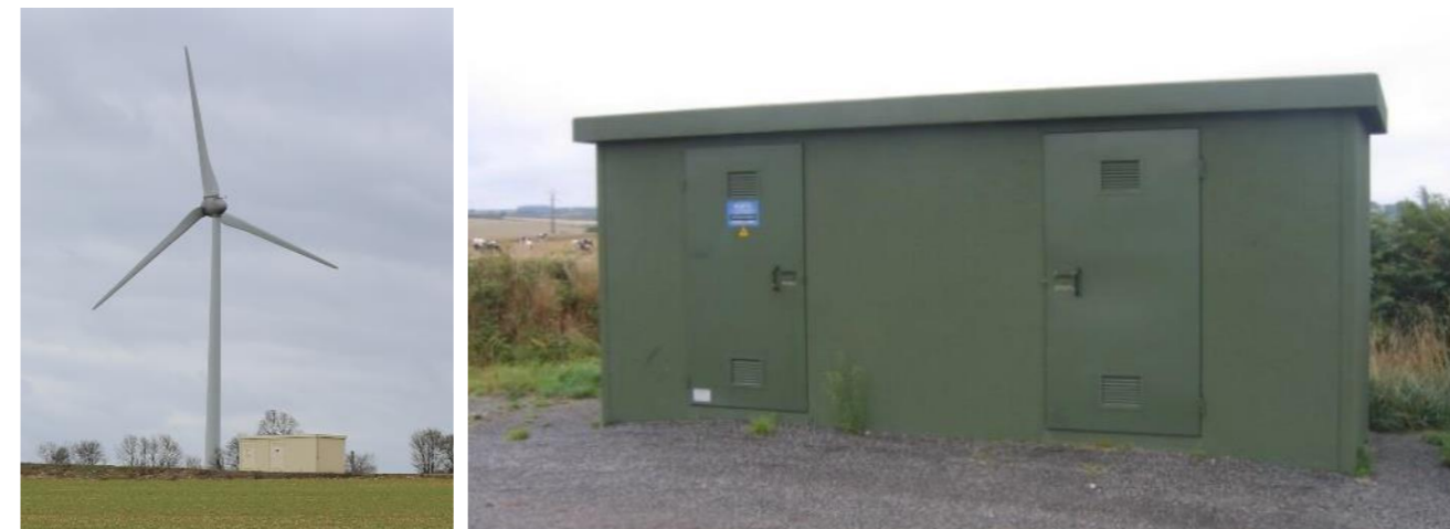
Figure 6 : exemples de poste de livraison électrique
