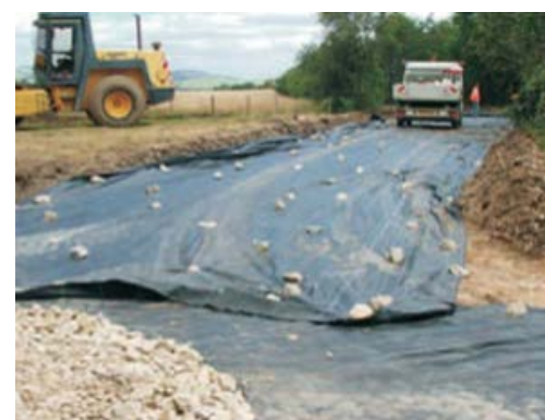
Pose d'un géotextile (à gauche), état final d'une plate-forme (à droite). Source : EDF Renouvelables
