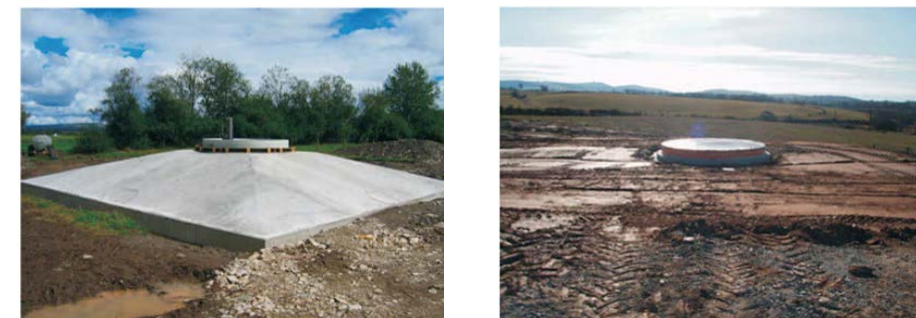
Massif béton terminé (à gauche), état final après remblaiement (à droite) Source : EDF Renouvelables
