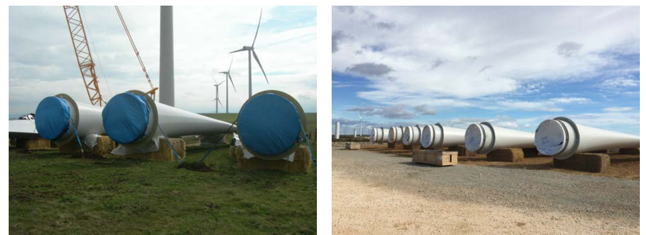
Les aires de stockage du chantier ne nécessitent pas forcément des travaux impactants. Ici stockage de pales sur prairie ou labour, sur balles de paille sans terrassement (Photos © EDF Renouvelables).
