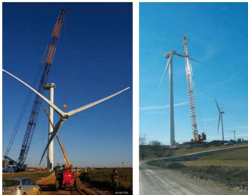
Montage du rotor (à gauche), Montage « pale par pale » (à droite)
