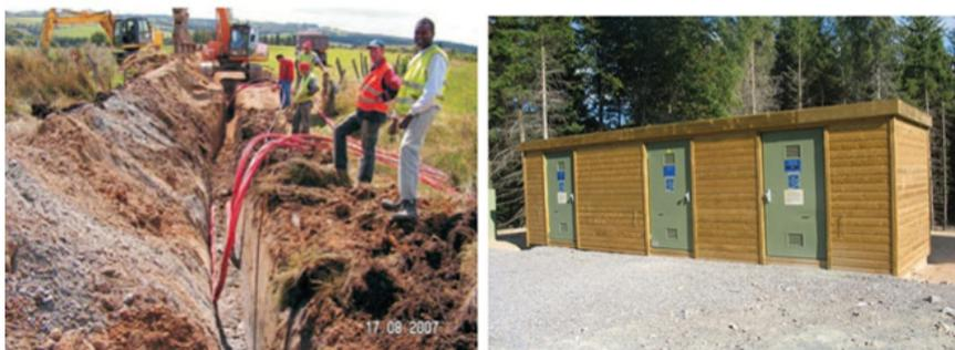
Photographie 6 : Déroutage et pose des câbles (à gauche), exemple de poste de livraison (à droite)
