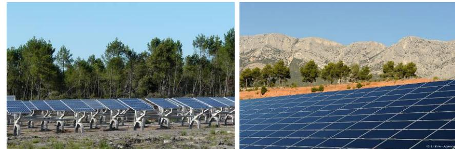
Photographie 1 : Structures solaires (à gauche: les trackers de la centrale de Gabardan (40) qui suivent le soleil ; à droite : structures fixes à Puyloubier (13)) - Source : EDF EN
