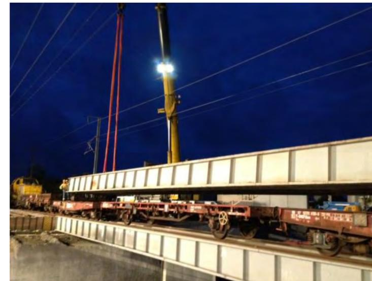
**Fig. 61.** Mise en place des tabliers auxiliaires (source : SNCF Réseau)
