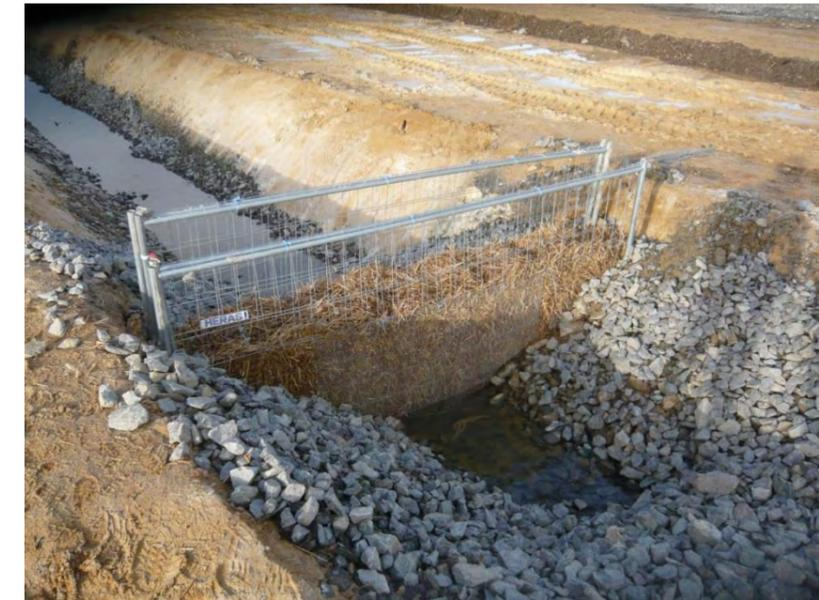
**Fig. 67.** Mise en place de filtre à paille avant rejet au milieu naturel (source : ARTELIA, 2015)
