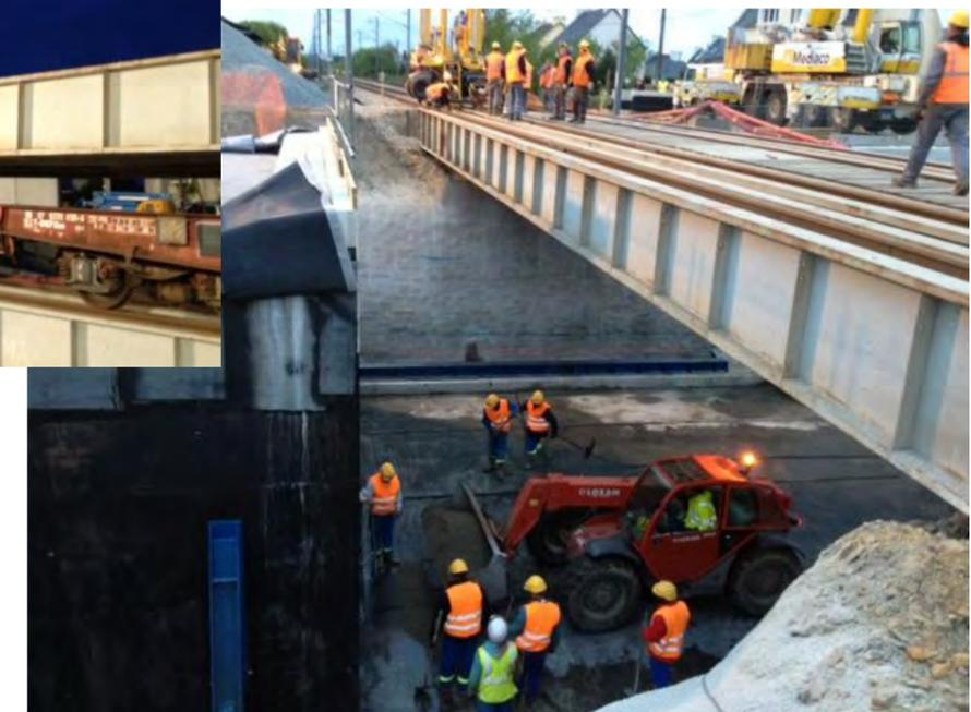
**Phase 5 : Terrassement sous tabliers auxiliaires et préfabrication de l'ouvrage :** terrassement au BRH et déroctage par préforage ; réalisation du radier drainant et préfabrication ouvrage
