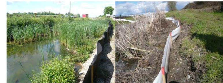
**Fig. 68.** Mise en place de clôtures temporaires vis-à-vis des zones naturelles sensibles (source : ARTELIA, 2015)
