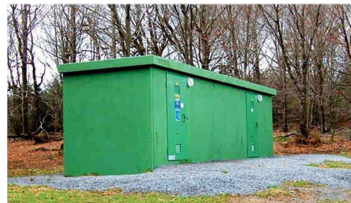
Photo 5 : Un exemple de poste de livraison électrique
