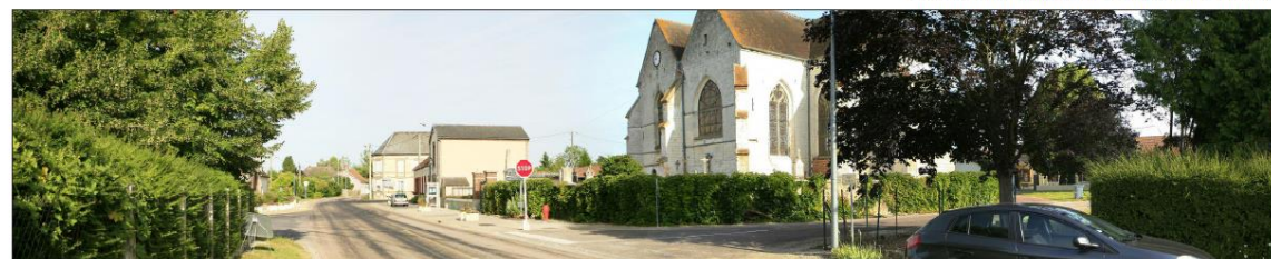
Vue du site avant projet
