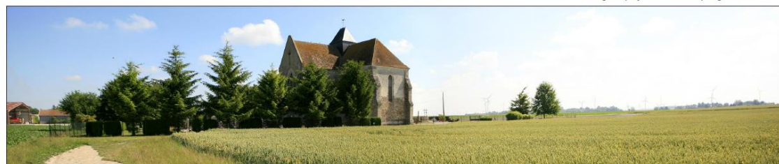
Vue du site avant projet
