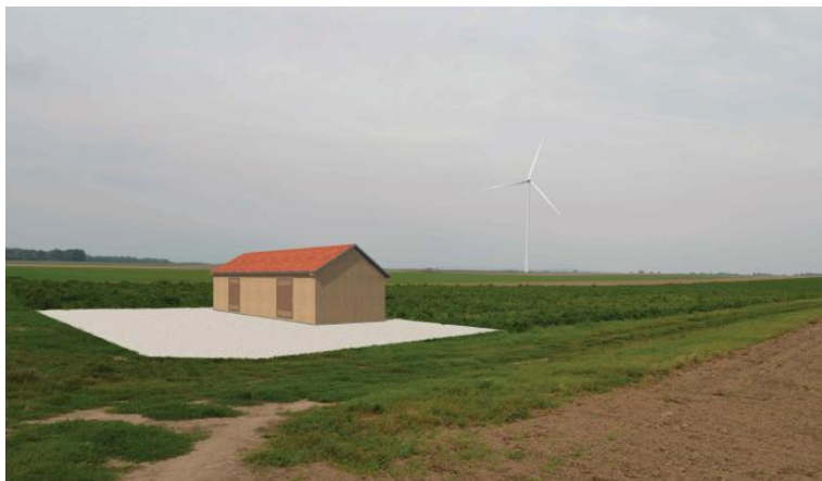
Figure 5 : Présentation des postes de livraison regroupés en une seule structure
