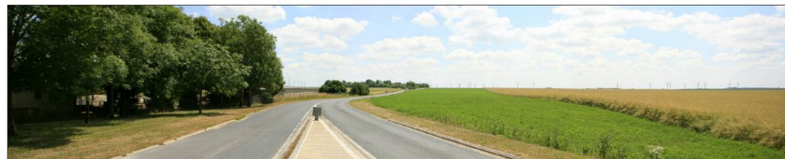
Vue du site avant projet
