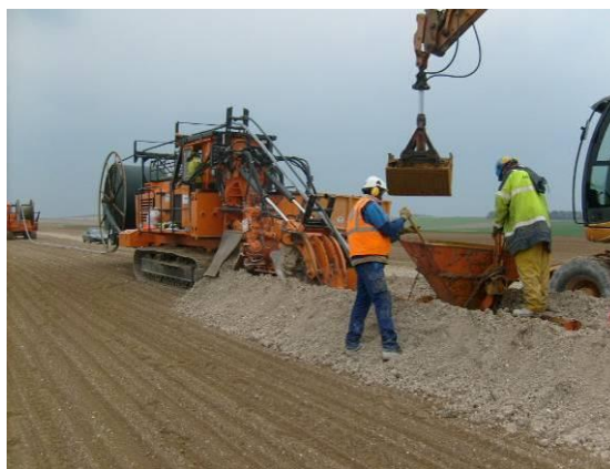
Photo 7 : Tranchée pour l'enfouissement des câbles électriques
