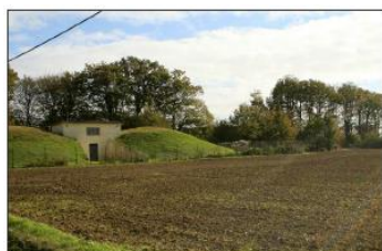
Vue d'un château d'eau enterré
