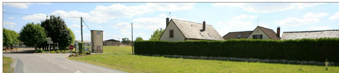
Vue du site avant projet
