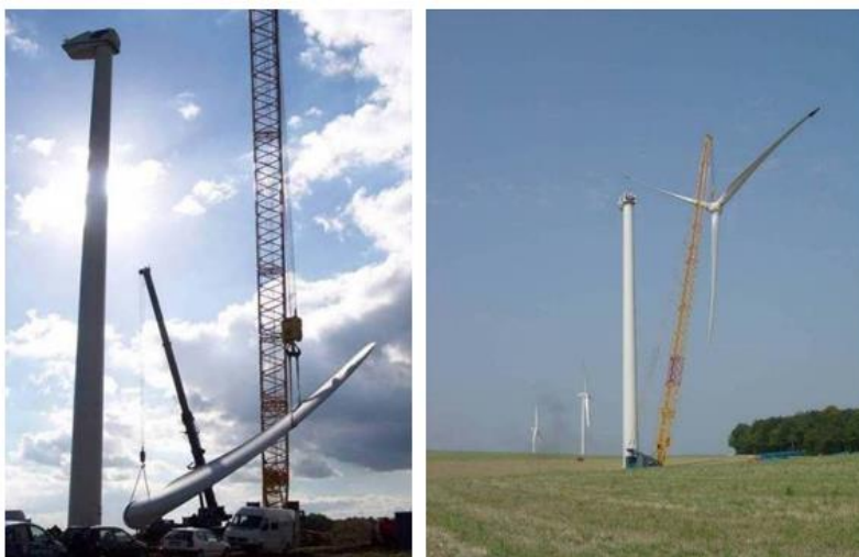
Photo 5 : Grue de montage et élevage de rotor
