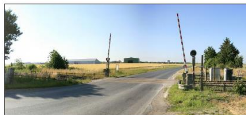
Vue de la voie ferrée, à Fère-Champenoise
