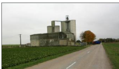
Silo, à Plancy-l'Abbaye
