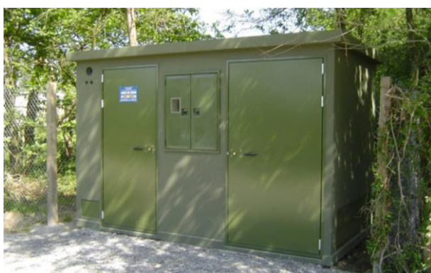
Figure 128 : Exemple de postes de livraison en béton vert sombre
