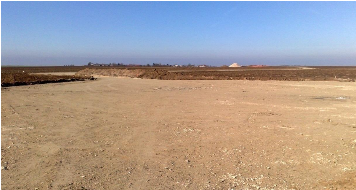
Figure 112 : Exemple d'aire de montage, grave compactée sur géotextile
