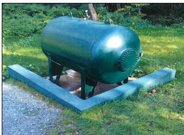
Figure 11 : Réservoir anti-bélier
