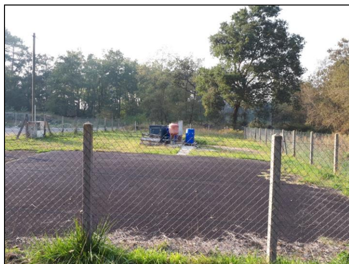
2 - Forage de Cap de Hé
