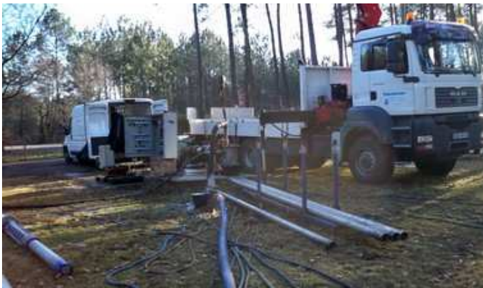
Diagnostic de l'ouvrage réalisé en 2011
