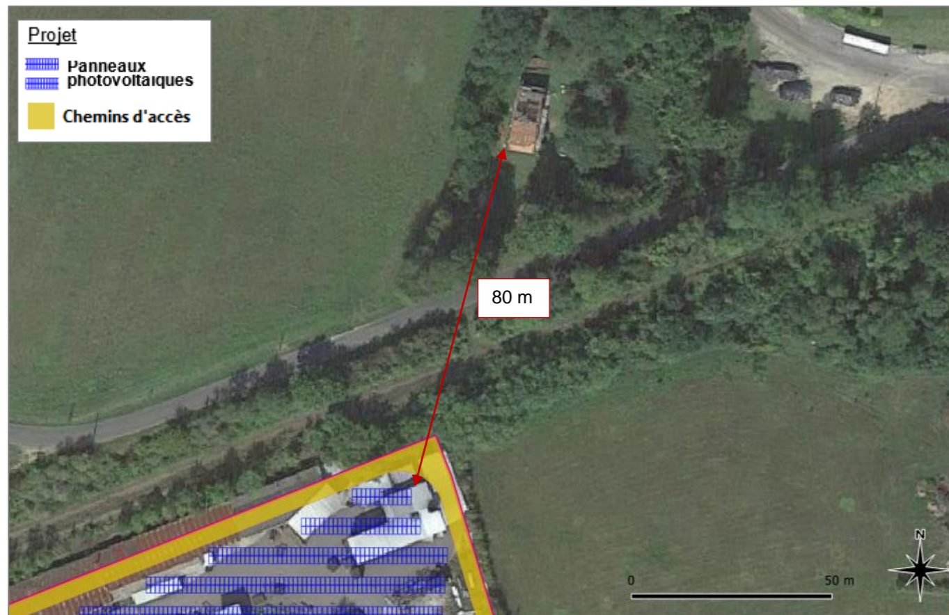
Figure 133 : Distance entre les installations photovoltaïques et l'habitation la plus proche
