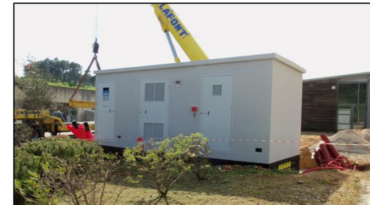
Figure 10 : Photo de l'installation du poste de livraison centrale solaire du pôle mécanique (Grand Alès) Total Energies
