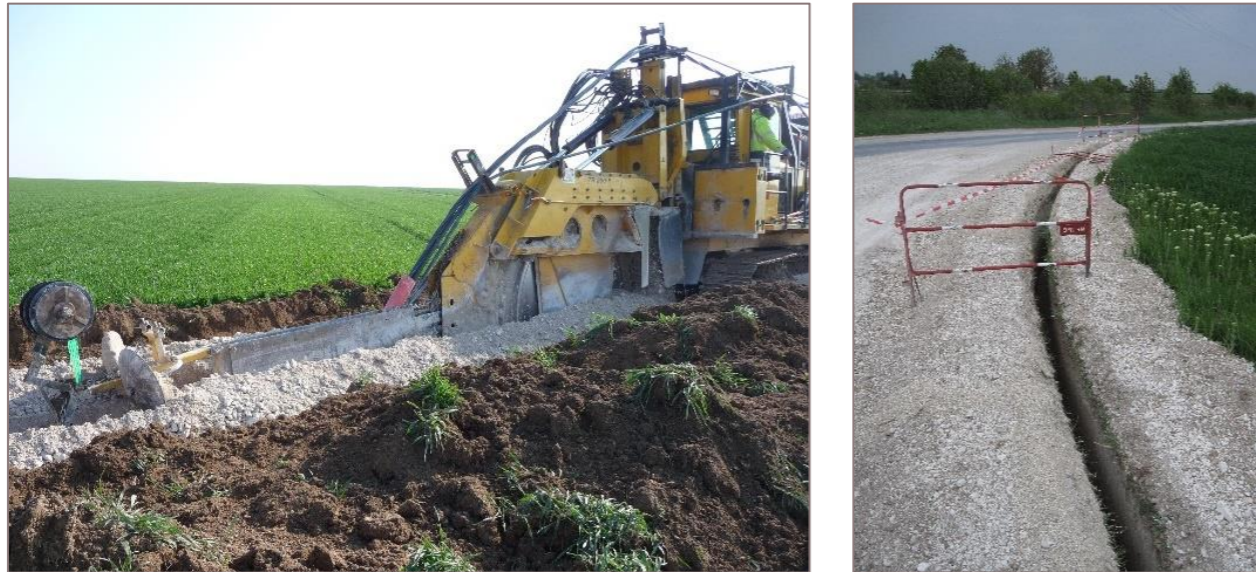
Figure 16 : Exemple de tranchée réalisée
