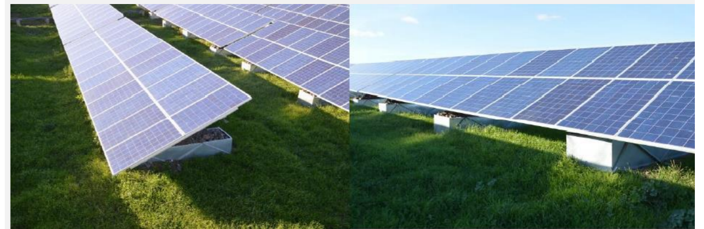
Figure 134 : Présentation de la méthode utilisée des plots autoportants
