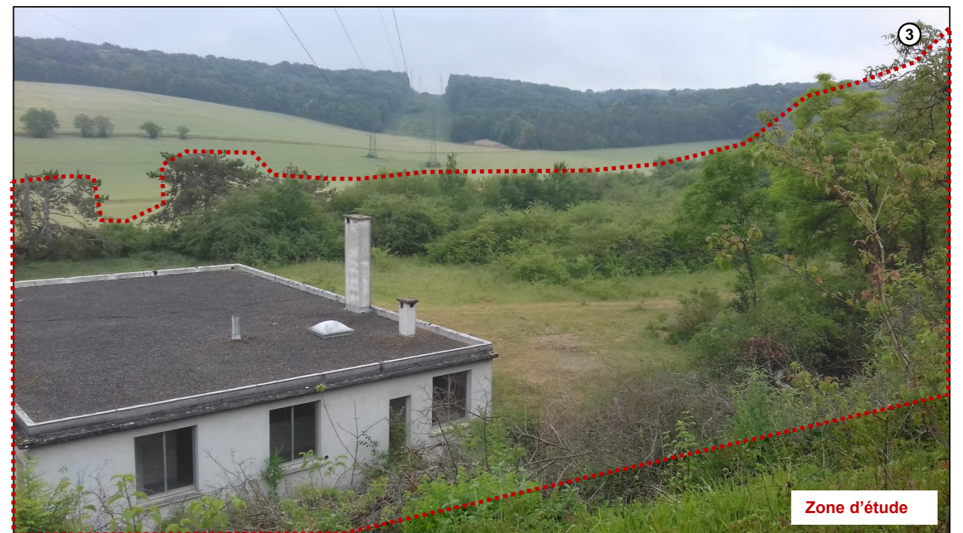
Figure 101 : Vue depuis la limite Nord de la zone d'étude ; la partie Est est composée de bâti industriel abandonné
