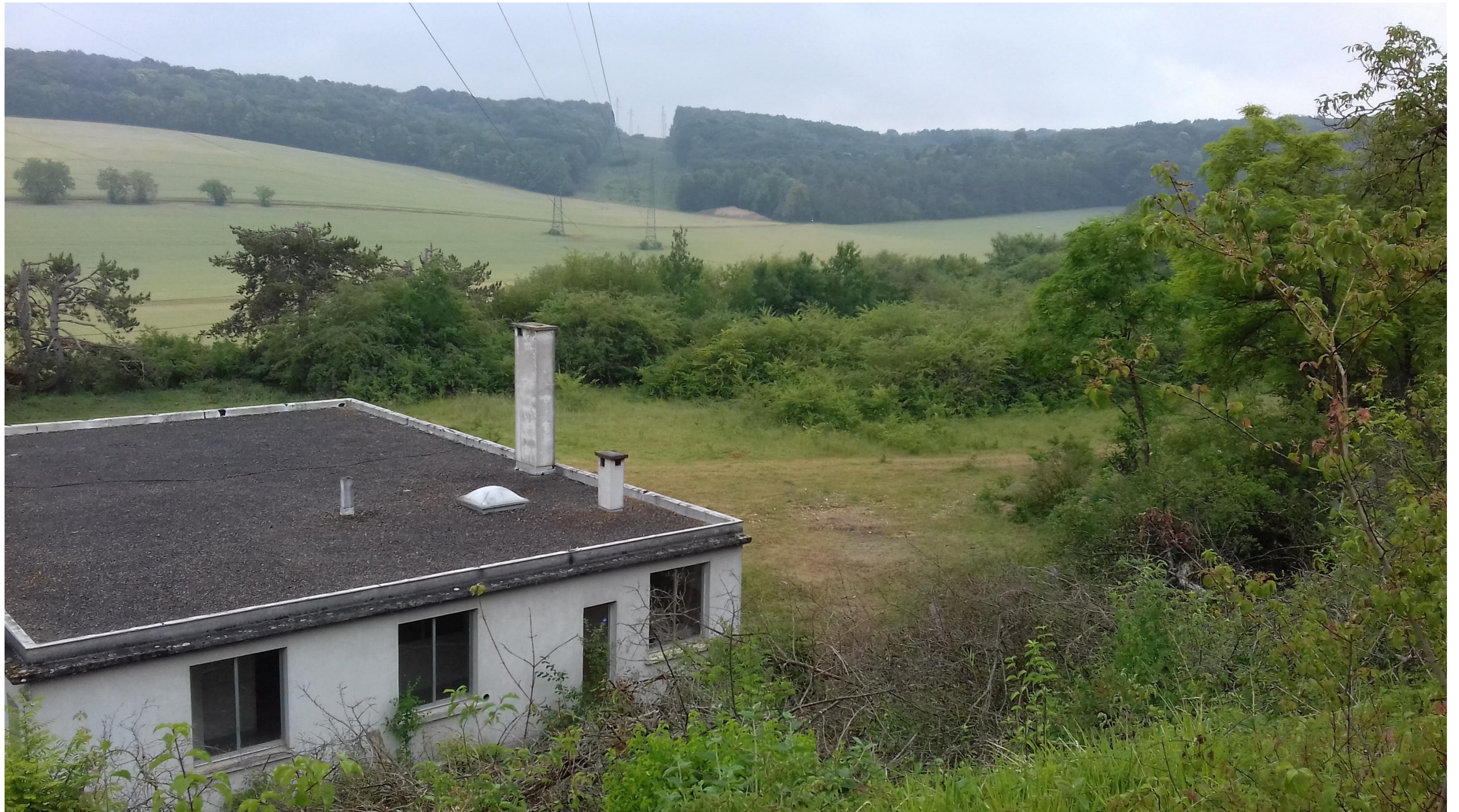
Figure 148 : Photographie n°3 de l'état initial : Vue depuis la limite Nord du projet ; la partie Est est composée de bâti industriel abandonné qui sera démantelé
