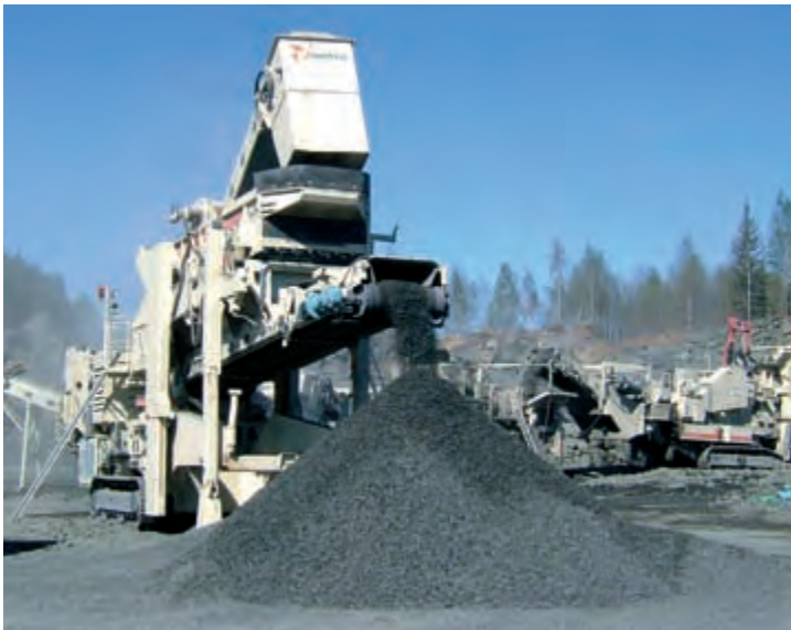
Processus de concassage et de criblage en trois étapes avec les Lokotracks LT110, LT300GP et LT300GPB.
