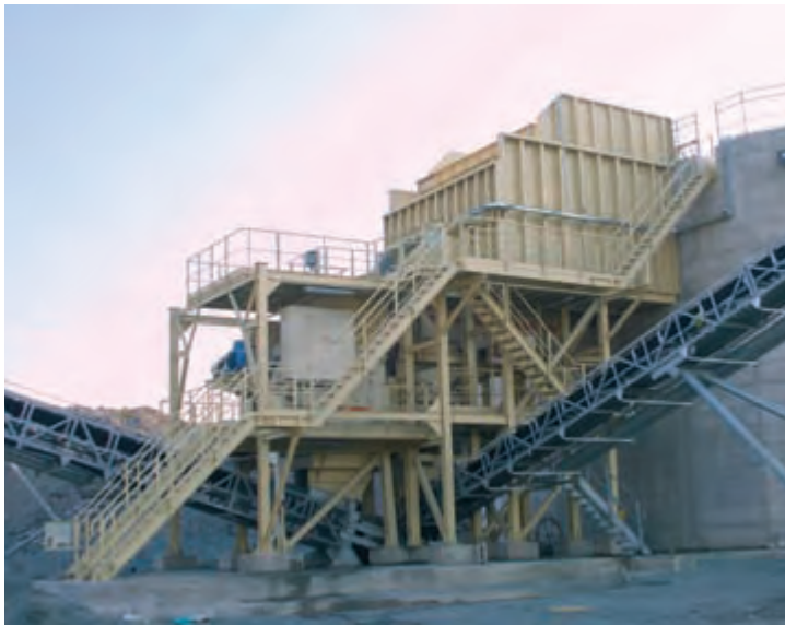
Un C125 pendant la phase d'installation dans une nouvelle unité de concassage primaire.
