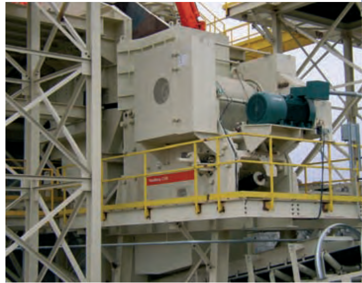
Un C145 pendant la phase d'installation dans une nouvelle unité de concassage primaire.
