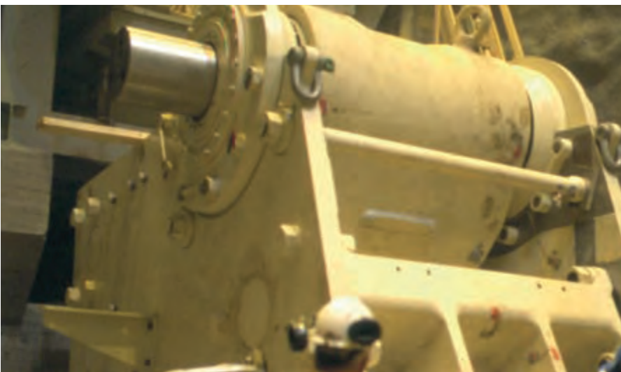
Un concasseur à mâchoires Nordberg C200 en phase d'assemblage dans une mine souterraine. Le concasseur a été transporté en pièces détachées et assemblé sous terre.
