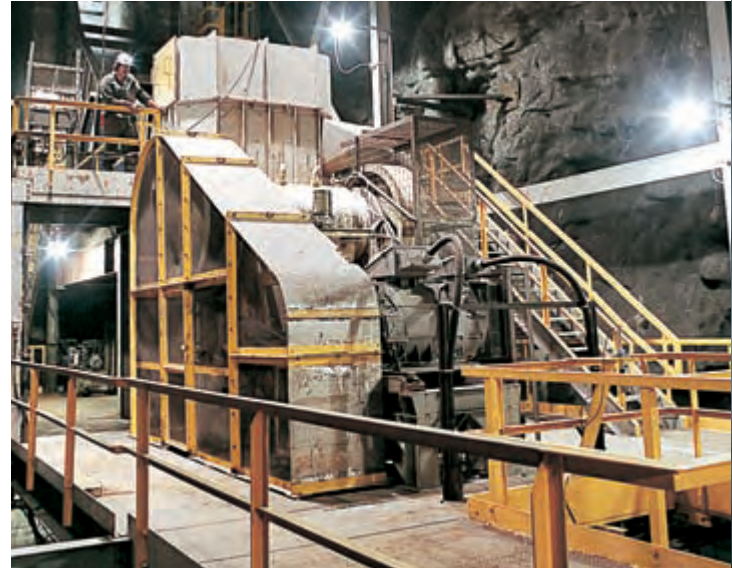
C160 dans une mine d'or souterraine.
