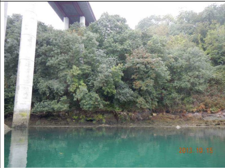
Photographie 5 (n°5 sur Figure 99: Localisation des prises de vue) La végétation sous le pont Châteaubriand, entre la rive et la pile P2, déterminé en habitat d'intérêt communautaire prioritaire lors des inventaires réalisés en 2013. La végétation au niveau de l'ancienne piste d'accès (photographie 9) s'est bien redéveloppée.
