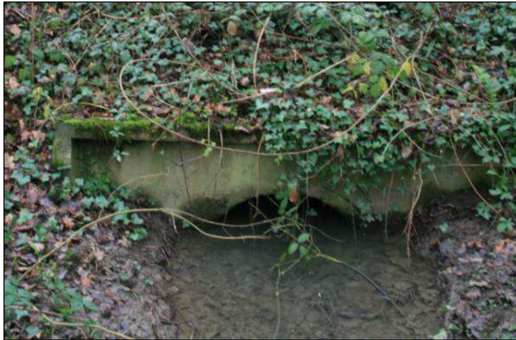
Figure 9 : Vue de la buse existante (source ARCADIS)
