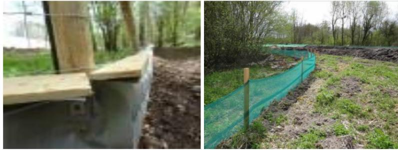
Le dispositif devra strictement épouser les courbes du relief de manière à ne pas créer de trouée inférieure dans laquelle les individus pourraient s'engouffrer et rejoindre ainsi les zones de chantier. L'imperméabilité du dispositif doit être maximale. Pour s'en assurer, un écologue de chantier vérifiera la bonne mise en place du dispositif et s'assurera de son maintien en bon état fonctionnel tout le temps de la mise en œuvre de la mesure.
