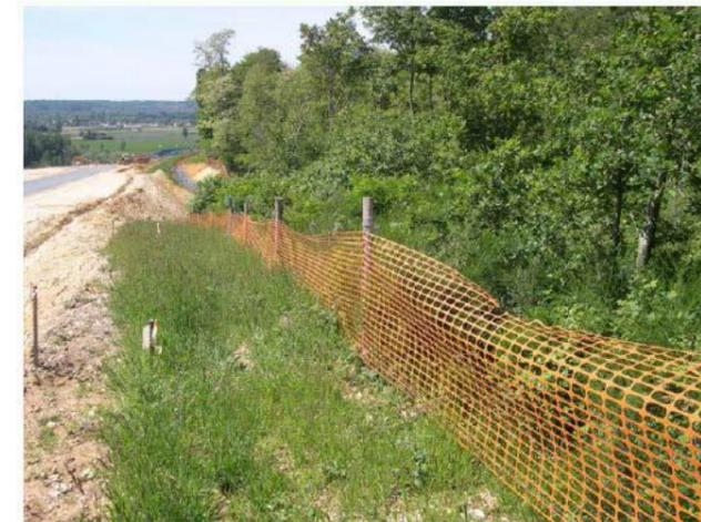
**Figure 73 : Type de barrière à mettre en place**
