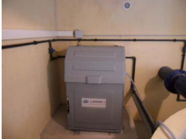
**Photographie 13 : Echantillonneur automatique**
