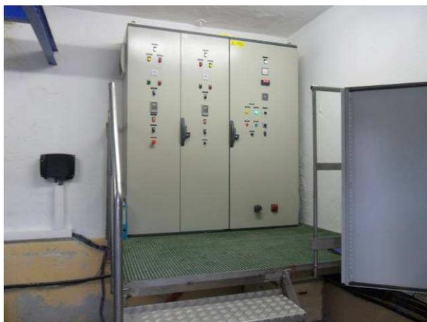
Photographie 4 : Détail des équipements salle est : pompes de surface (à gauche), armoire électrique et système de télégestion (à droite)
