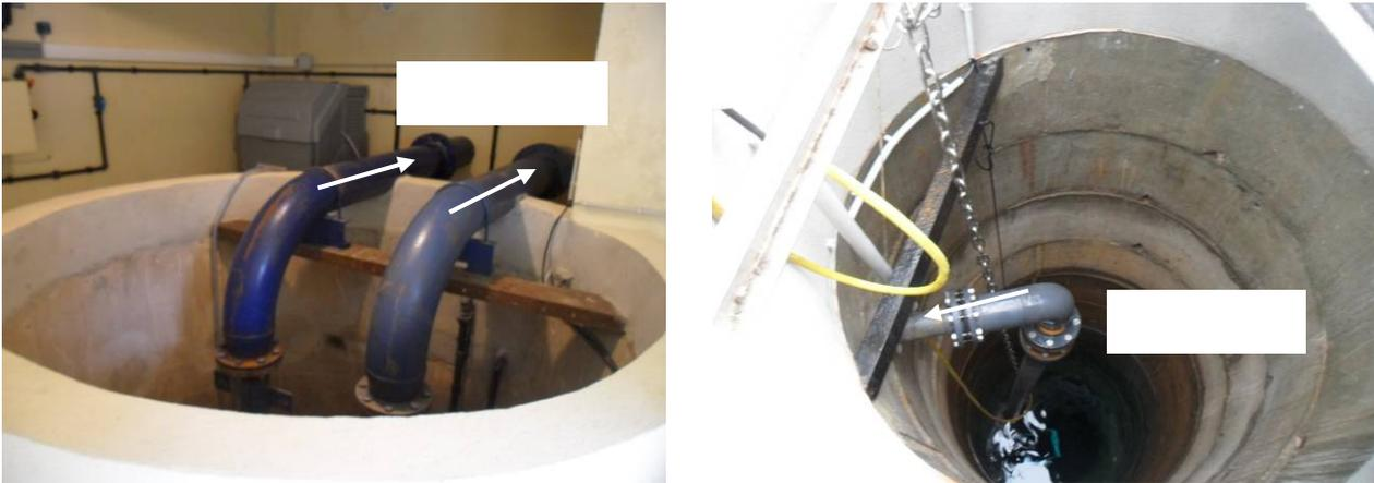
**Photographie 6 : Détail du cuvelage et des conduites de refoulement : puits principal (à gauche) puits extérieur (à droite)**
