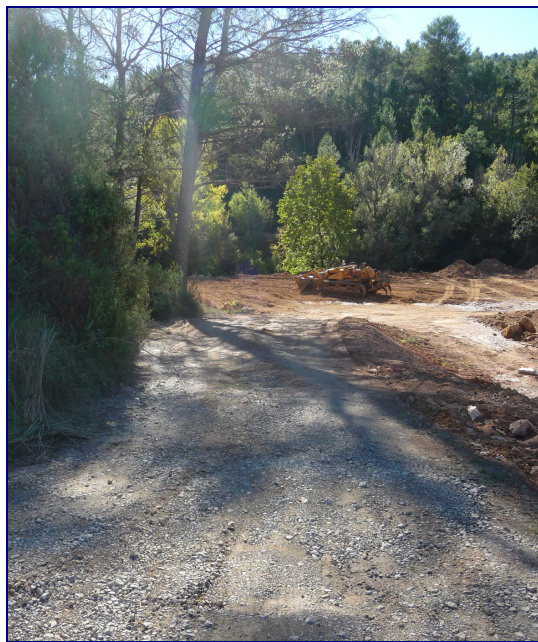
Photo 16 : Voie communale d'accès à la plateforme
