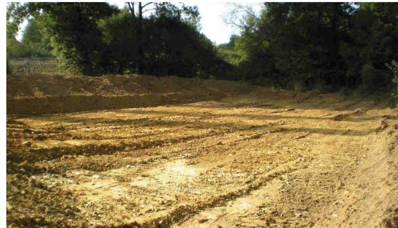
Photo 3 : Un exemple de décapage d'une parcelle pour la création d'une zone humide
