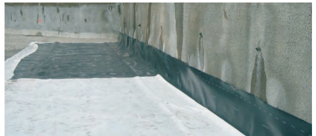
exemple de réalisation d'aire étanche avec la Géomembrane Stratex PEHD
