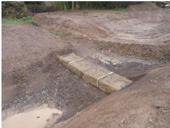
Figure 45: Filtre chargé de retenir les matières en suspension - Chantier SINBIO de déplacement du Nizerand (69)
