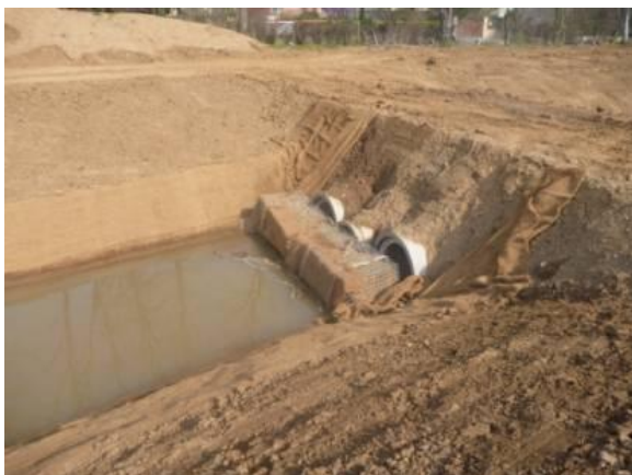
Figure 45: Filtre chargé de retenir les matières en suspension - Chantier SINBIO de déplacement du Nizerand (69)
