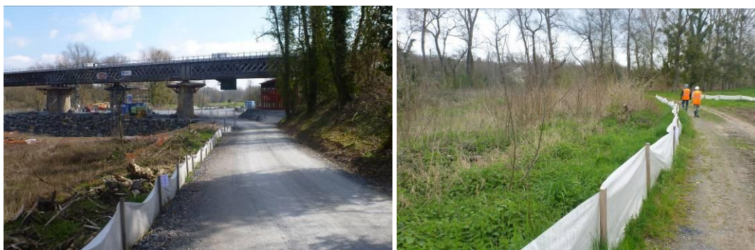
Figure 47: Exemple de barrières envisagées pour isoler la zone de travaux
