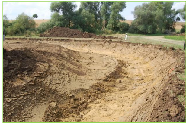
Illustration de la dépose de matériaux terreux avant le remblaiement de l'ancien lit mineur.
